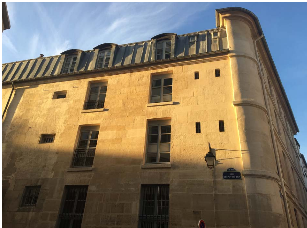
Façade rue du Pot-de-Fer, après restauration.
