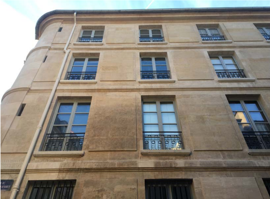
Façade rue Tournefort après restauration
