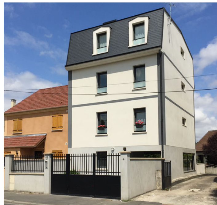
Construction de 3 logements collectifs à Sevran (93)
