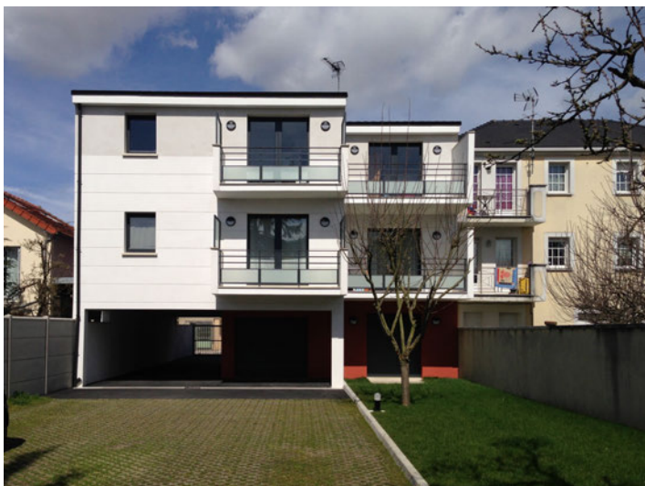
Construction de 4 logements collectifs à Sevran (93)
