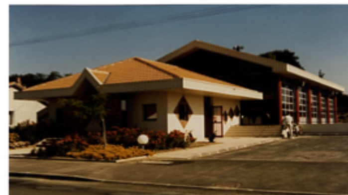
CENTRE DE SECOURS - Bouguenais
