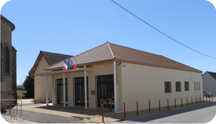
Reconstruction d'une mairie, Saint-Loup (03)
