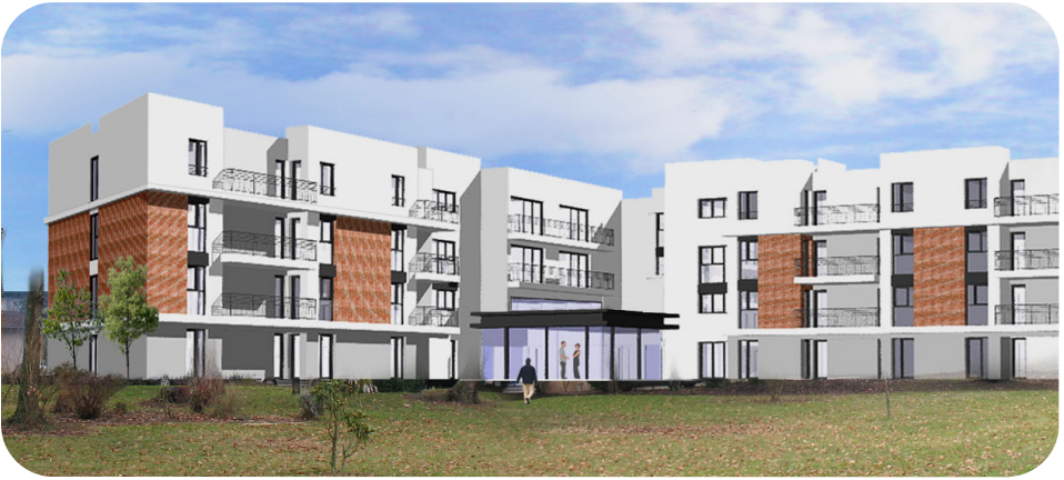
Construction d'une résidence sénior à Nevers (58)
