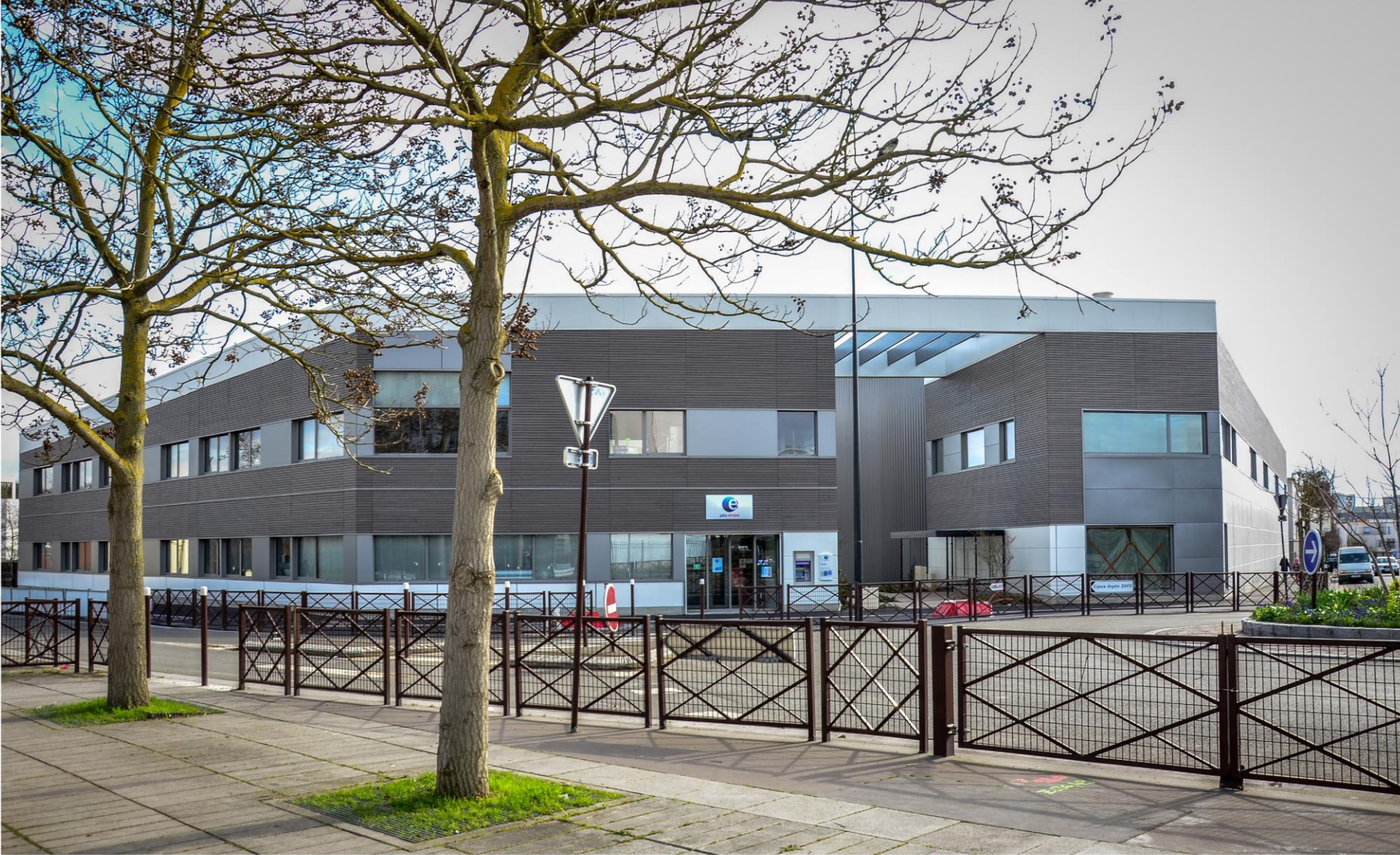
PARC D'ACTIVITES STAINS (93)
