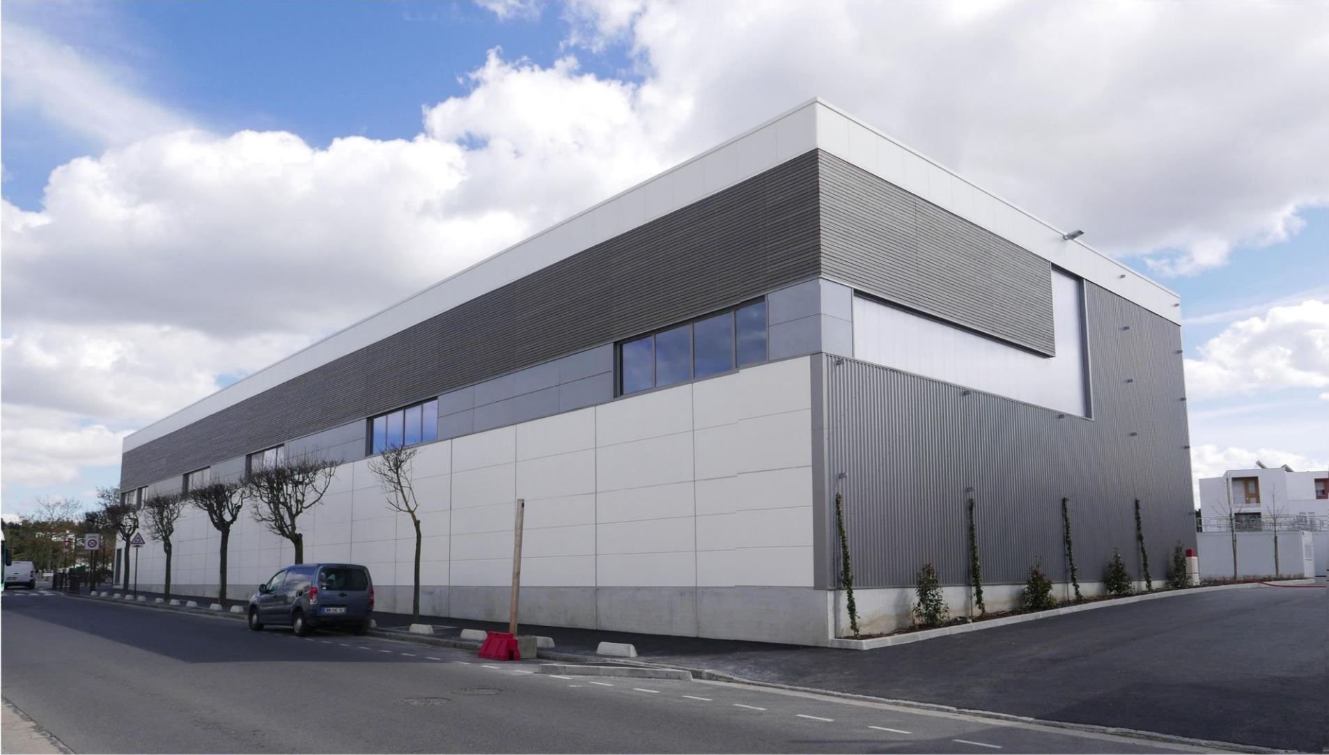
PARC D'ACTIVITES STAINS (93)
