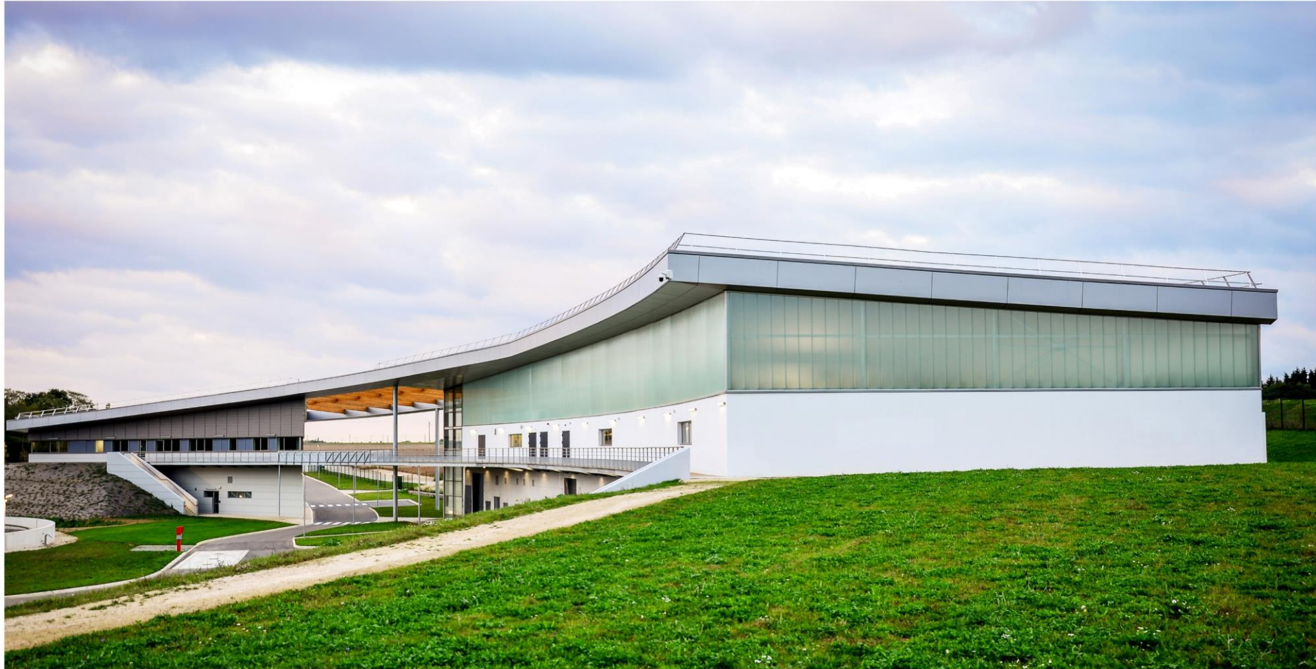
STATION D'ÉPURATION DE CHARTRES (28)
