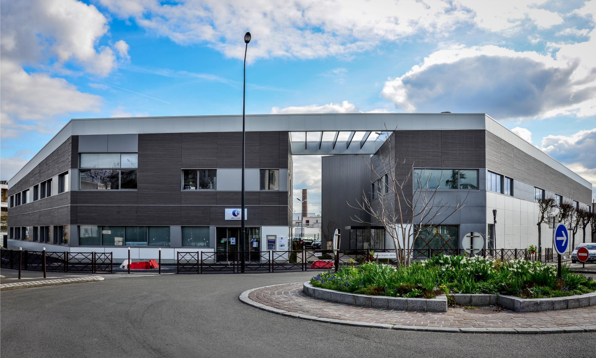
PARC D'ACTIVITES STAINS (93)
