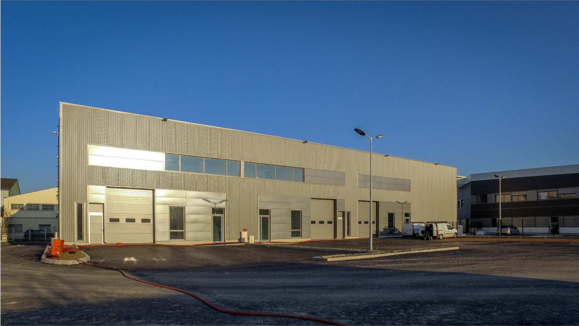
PARC D'ACTIVITES STAINS (93)
