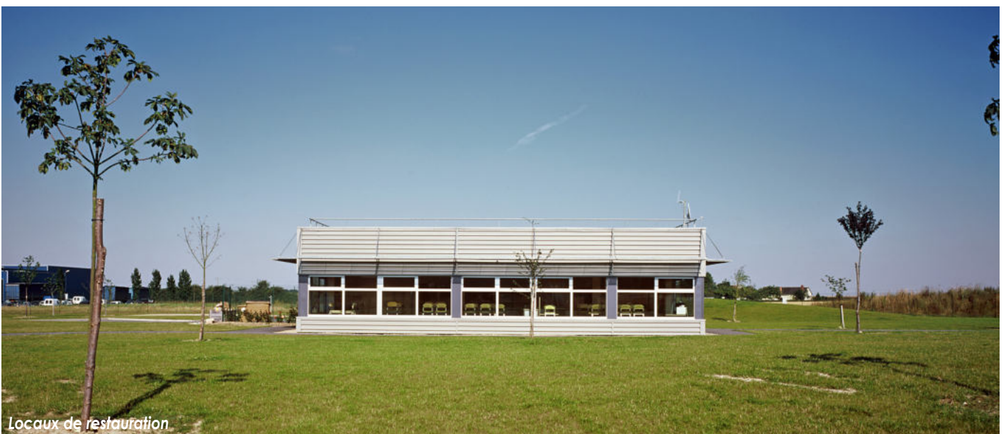
Façade principale - accueil public
