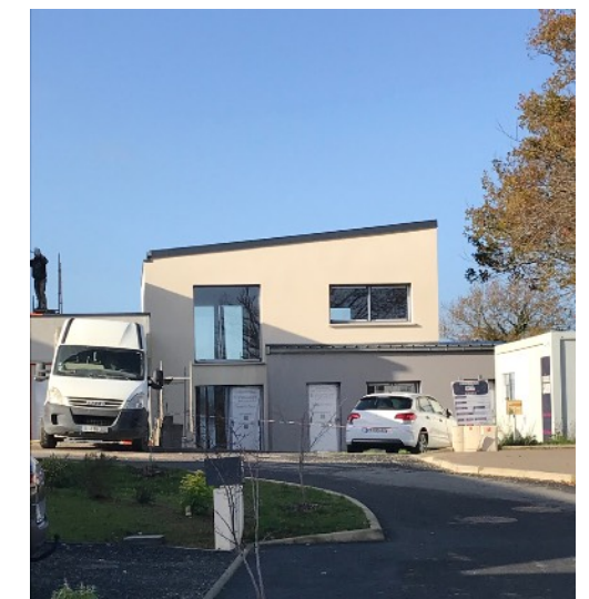
Photos de chantier
