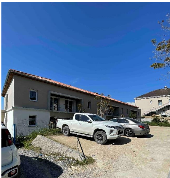
Chantier en cours
