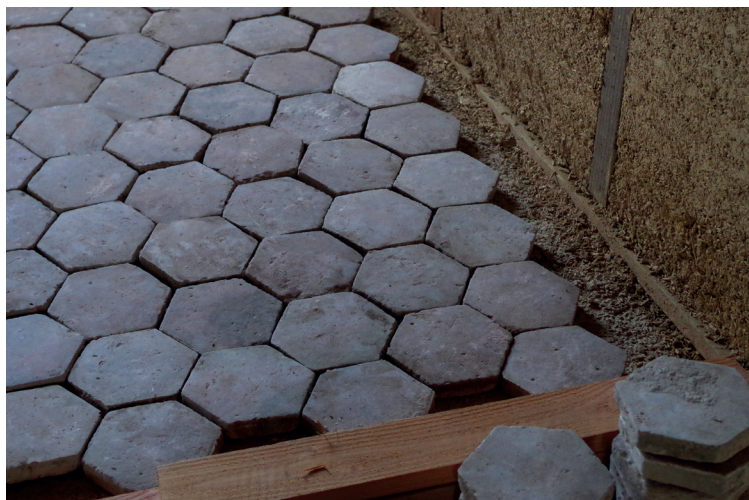
Auto-réhabilitation d'une ancienne ferme en pierre à Fussey
