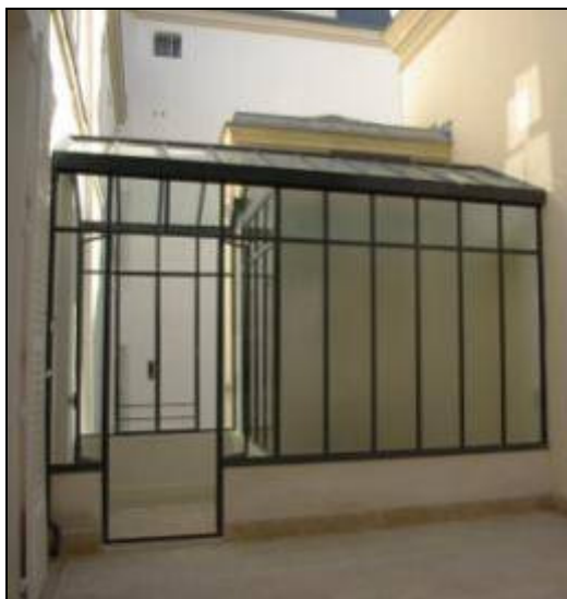
VERRIERE SUR TERRASSE DU 1ER ETAGE
