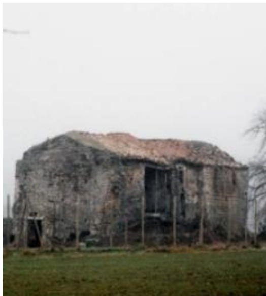
ETAT EXISTANT AVANT TRAVAUX
