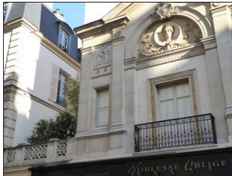
VUE VERS TERRASSE DU 1ER ETAGE 27 RUE DE BELLECHASSE
