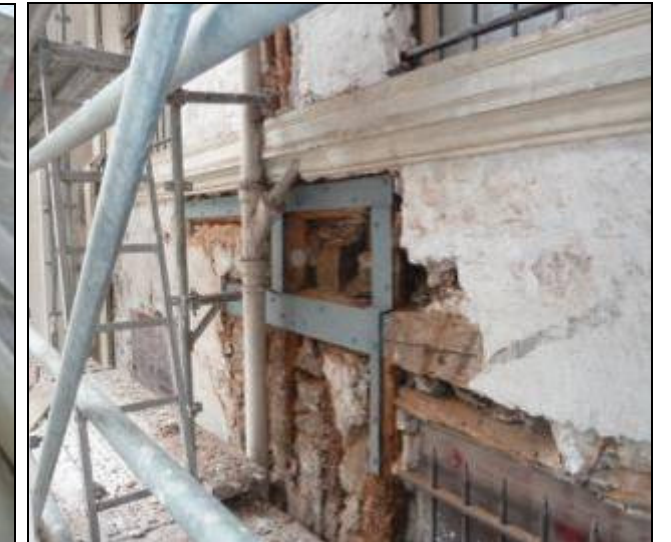
REPRISE PAN DE BOIS EN FACADE COUR, chantier en cours
