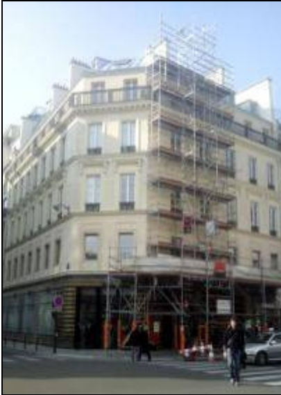
FACADE RUE, déchafaudage en cours
