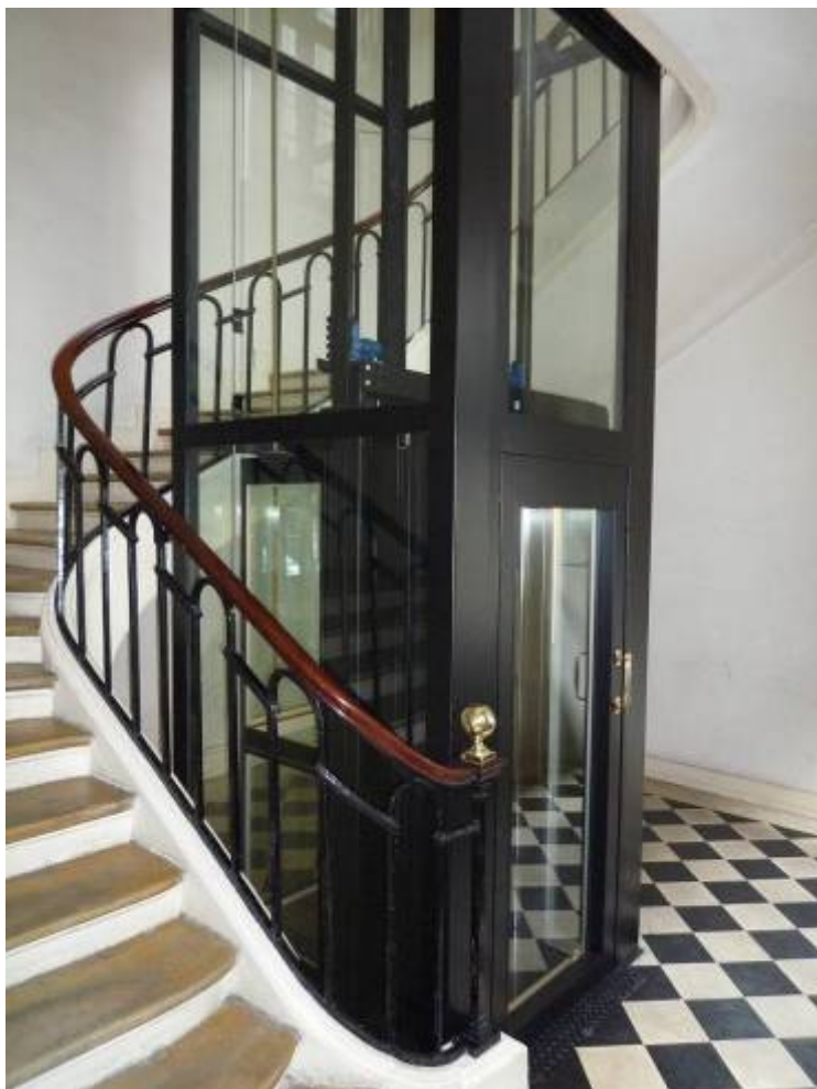
VUE DE L'ASCENCEUR AU REZ DE CHAUSSEE
