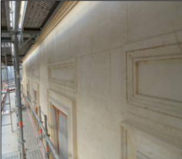
DETAILS DES MODENATURES EN FACADE RUE, chantier en cours
