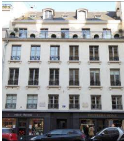
FACADE REALISEE RUE DE TOURNON
