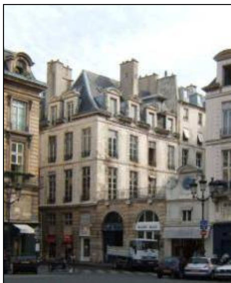
AVANT TRAVAUX - PLACE DES VICTOIRES -
