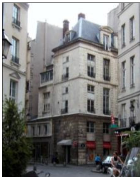
AVANT TRAVAUX - ANGLE RUE DU MAIL
