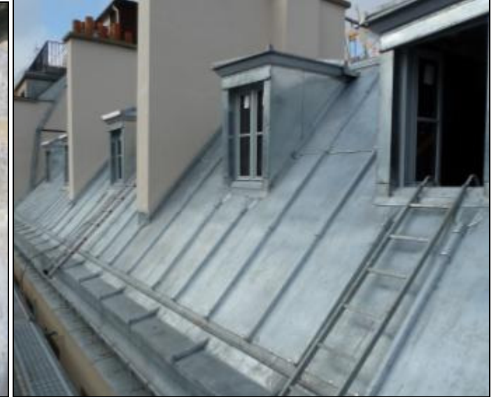
VERSANT RUE DE PROVENCE, couverture achevée
