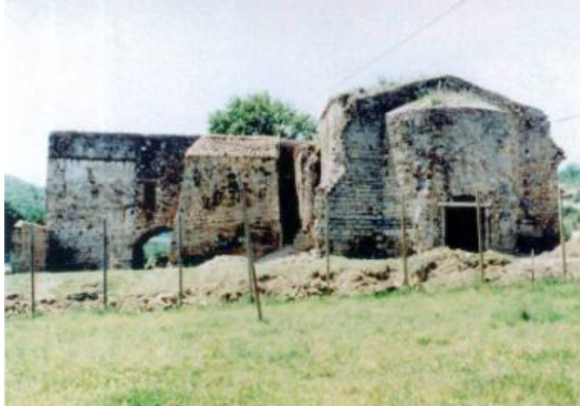
ETAT EXISTANT AVANT TRAVAUX
