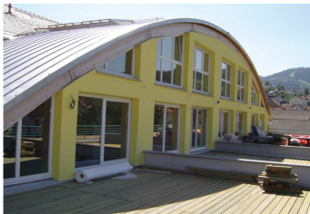
Réhabilitation de l'usine Hans à Gérardmer (88) Maître d'ouvrage : SCI LOCANEWS Architecte : Julien King-Georges Maître d'Œuvre : Construteck (Ivrazon 2004)
