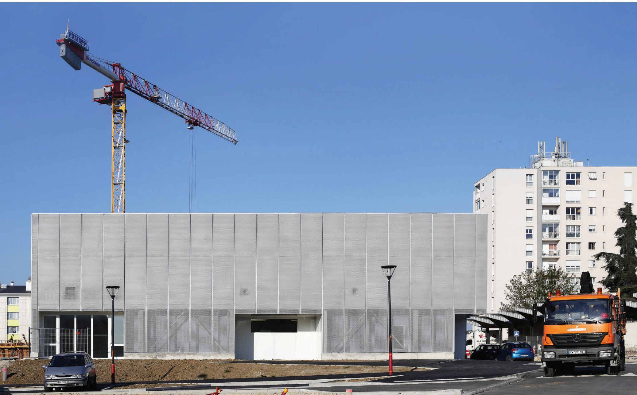
Restructurer, dépolluer, désamianter, fonctionner en site occupé
