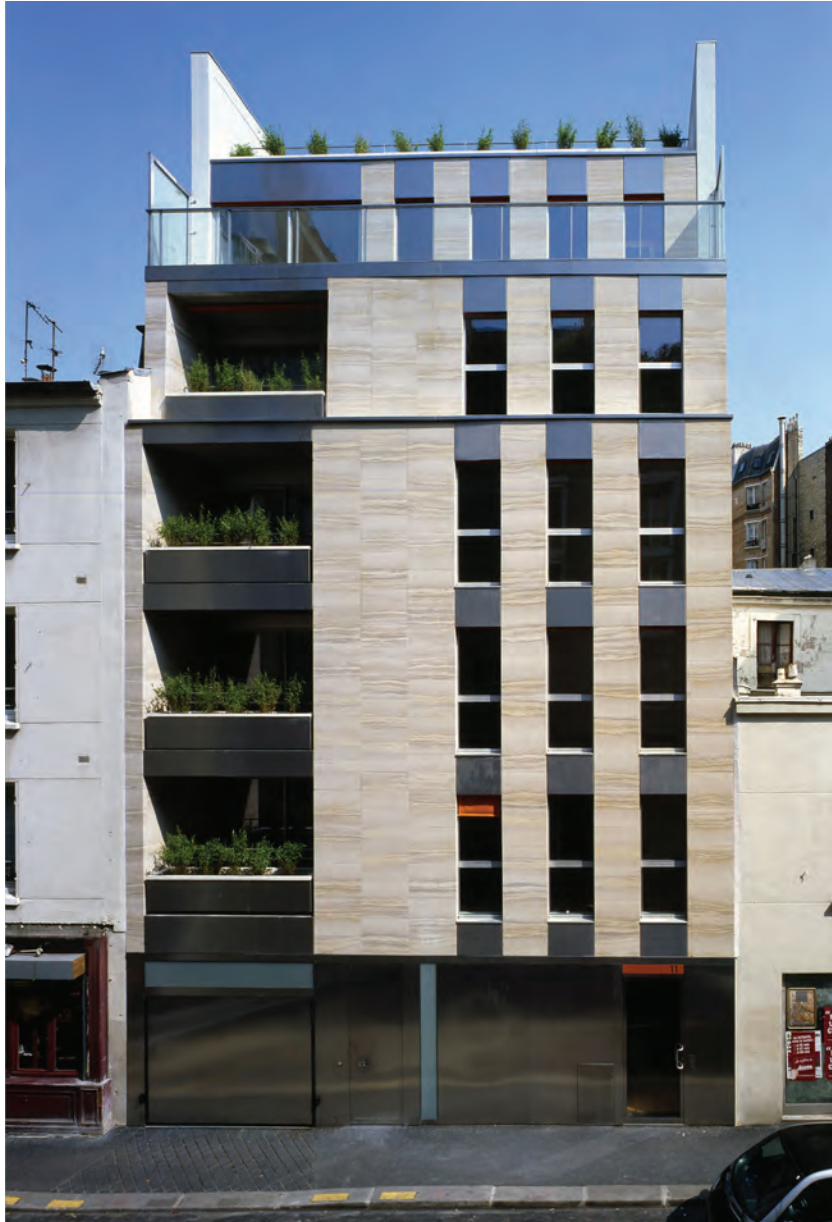
VUE GÉNÉRALE SUR LA FAÇADE RUE DOMBASLE
