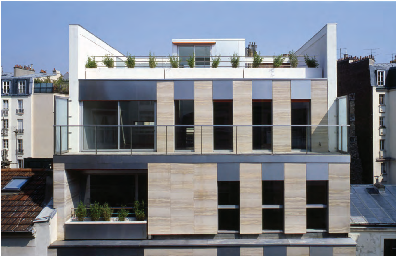
FACADE DU DUPLEX
