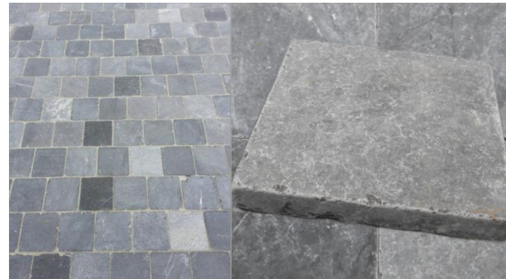
Habillage du cheminement devant les logements PMR en pavé du Vietnam
