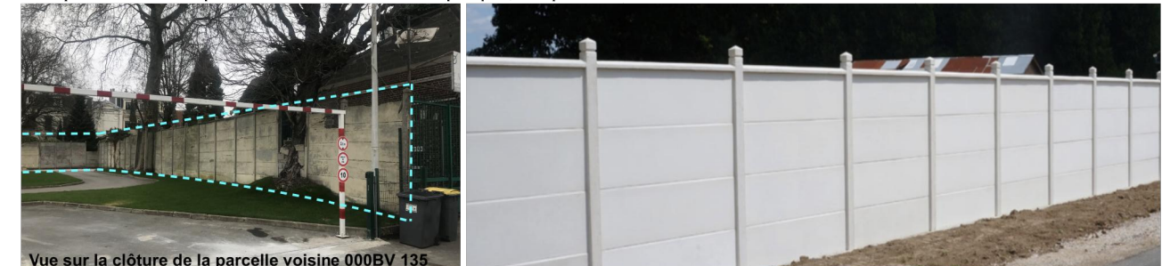
Vue sur la clôture de la parcelle voisine 000BV 135
