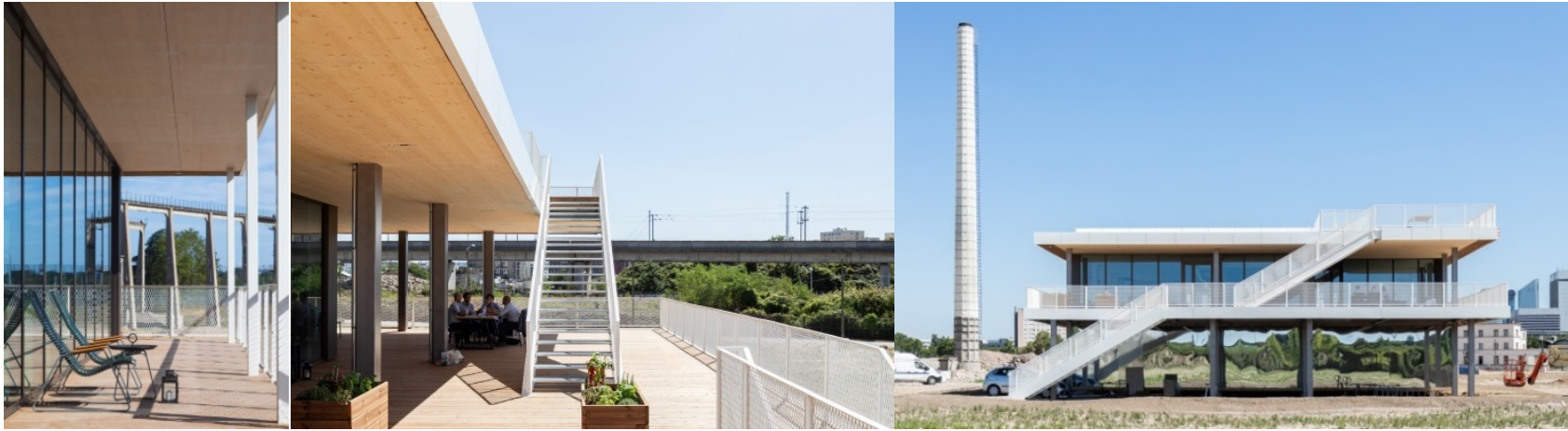
PAVILLON TEMOÏN, NANTERRE LECLERCQ ASSOCIES, Paris Arboretum Ecocampus, Marketing suite de 500 m 2 Structure BOIS LVL et CLT, label BBCA Woodeum, BNP Paribas Immobilier Etudes – chantier – Livraison : 2019
