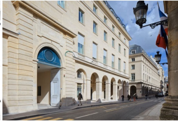
RÉHABILITATION DES IMMEUBLES DU SENAT 26-36 RUE DE VAUGIRARD, PARIS SAA – Architectes, Paris Programme mixte bureaux, crèche, gymnase Le Sénat, DAPJ - 10000m 2 HQE BBC Effinergie rénovation Etudes APS-APD--PRO : 2016-2017
