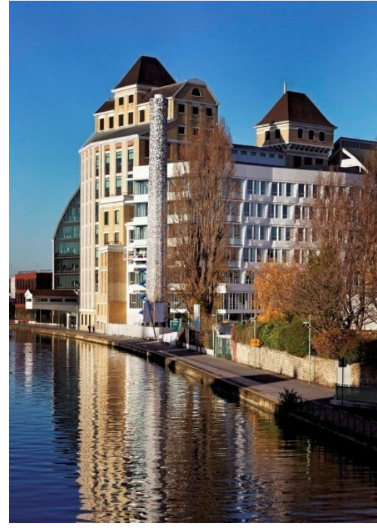
IMMEUBLE DE BUREAUX À PANTIN SAA - Architectes, Paris BNP Paribas Immobilier - 15 000m 2 BBC 2005 Effinergie , HQE Tertiaire exceptionnel Etudes : 2012-2013 Chantier : 2013 – livraison 2016
