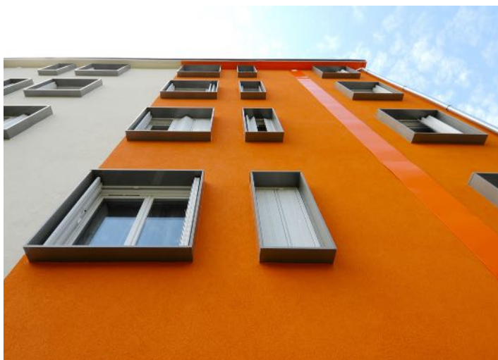
VUE SUR LA RUE TURGOT PHOTOS DU CHANTIER DÉTAIL CADRE FENÊTRE
