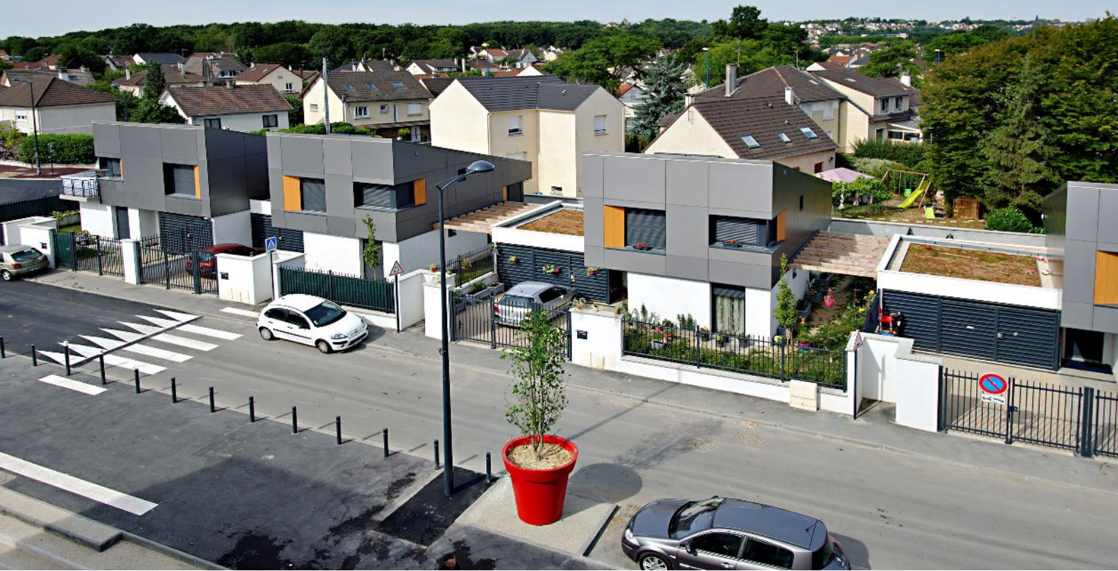
PHOTOS DE CHANTIER AVRIL 2015
