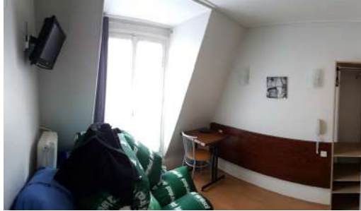
Vue d'une chambre sous comble avant travaux
