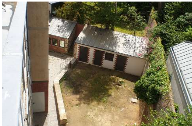
Vue de la façade sur jardin
