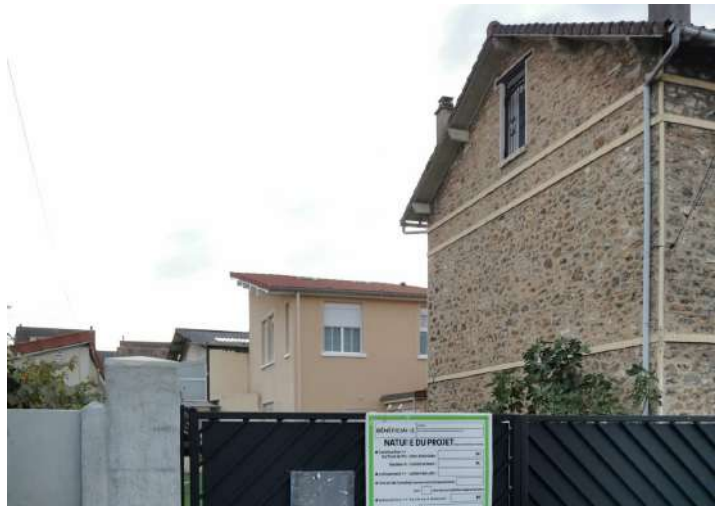
Vue du projet réalisé depuis la rue
