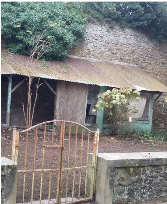
Vue des appentis existants dans le jardin
