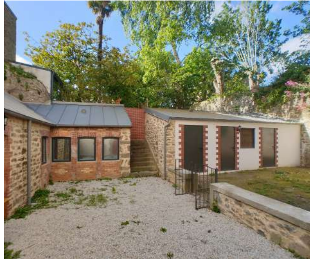
Vue des Celliers et locaux vélos et poubelles
