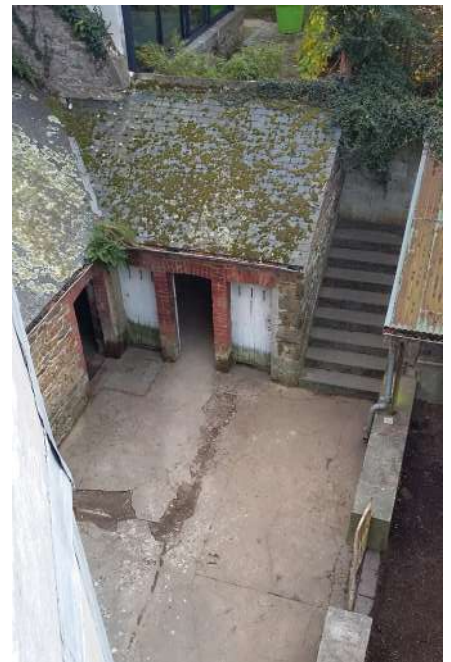
Vue des celliers existants
