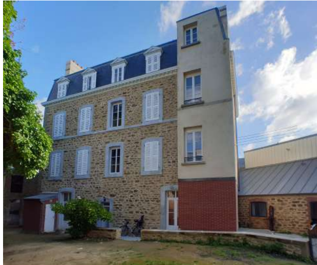
Vue de la façade sur jardin
