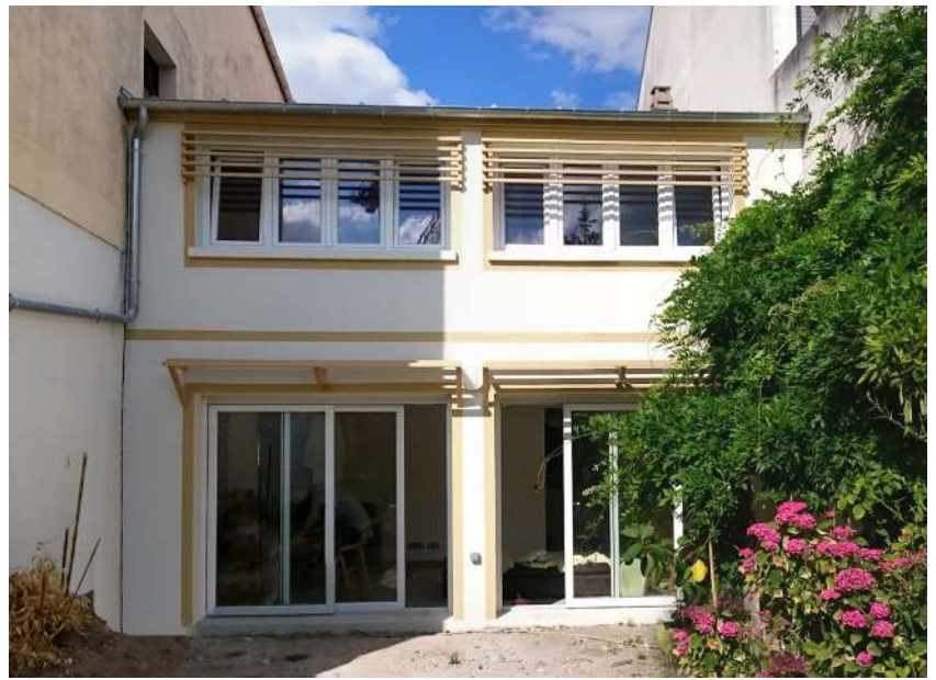
Façade sur jardin réalisée
