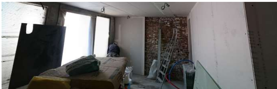
Vue du séjour lors du chantier
