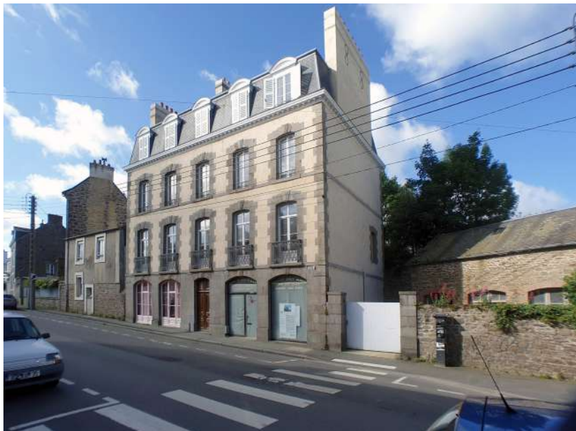
Vue de la façade sur rue avec commerces en RdC
