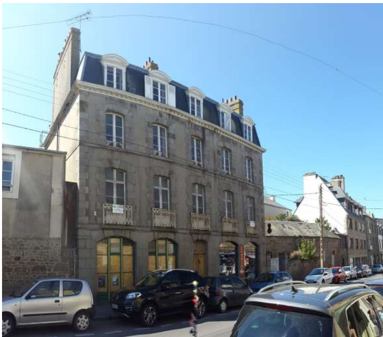
Vue de la façade sur rue existante
