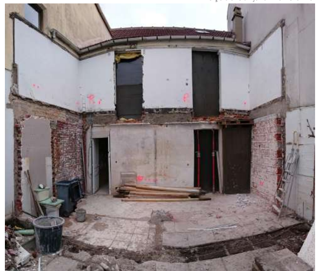
Photographie du chantier : démolitions
