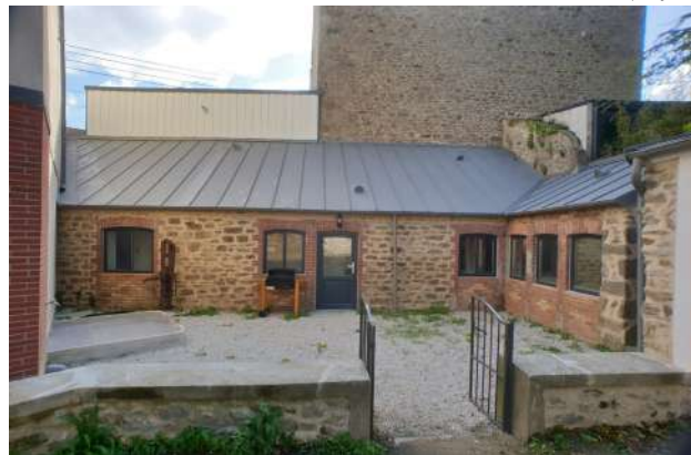
Vue des Celliers et locaux vélos et poubelles
