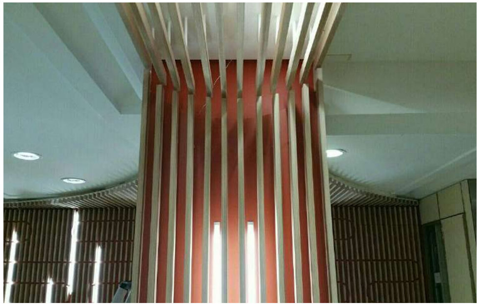
Détail sur plafond et habillage colonne : les "torchères"
