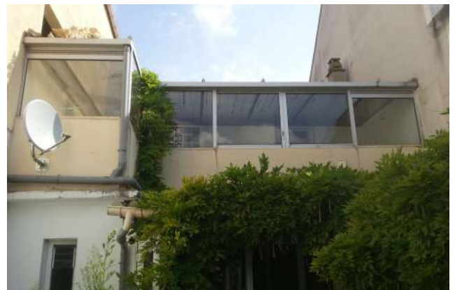
Façade sur jardin existante
