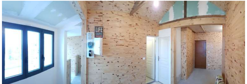
Vue depuis l'accès véranda
