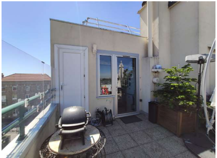
Photographie de l'accès terrasse réalisé
