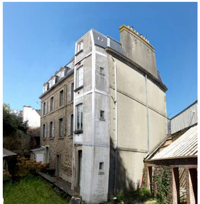
Vue de la façade sur jardin existante
