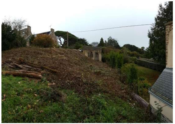
Vue de l'état existant - Garage
