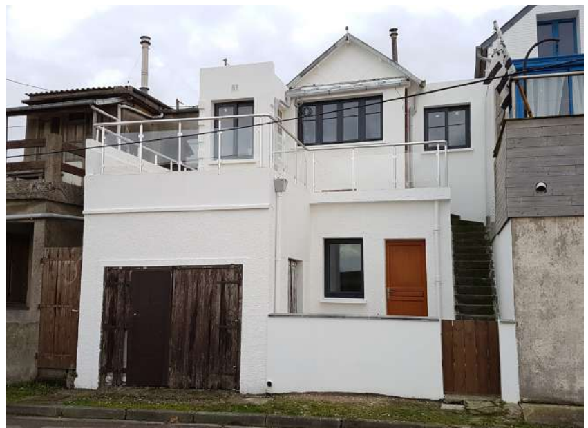
Vue de la façade côté bord de mer
