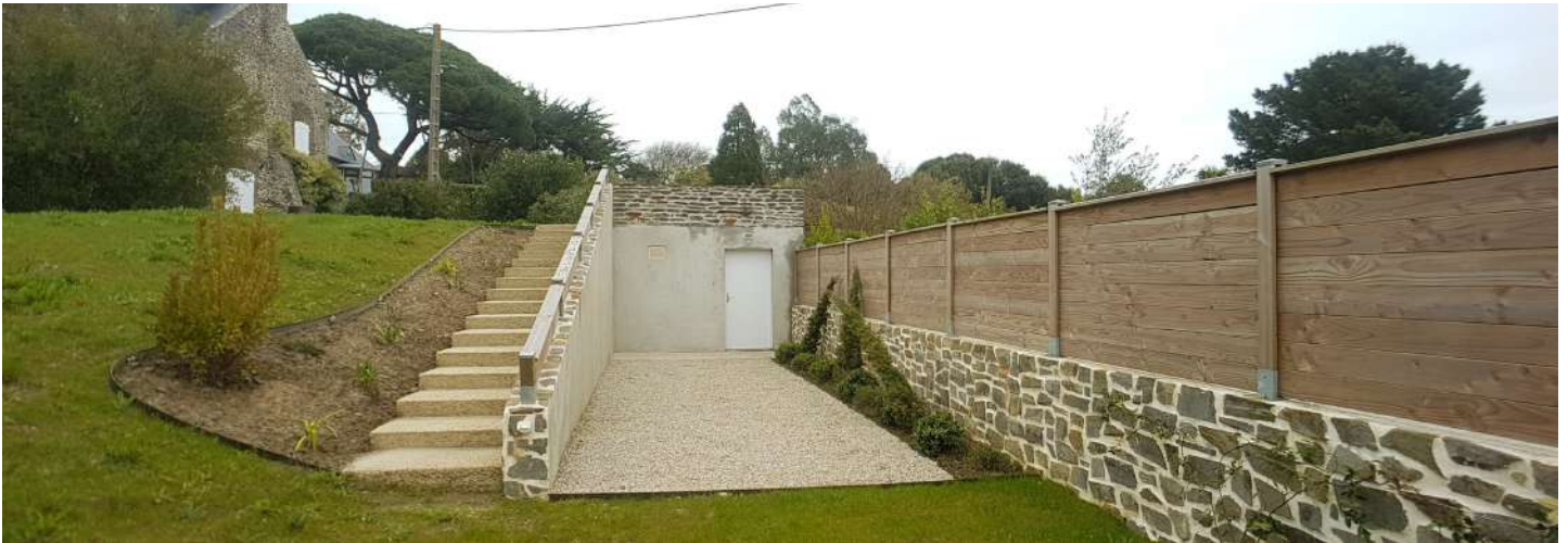
Vue de la réalisation depuis le bas du terrain
