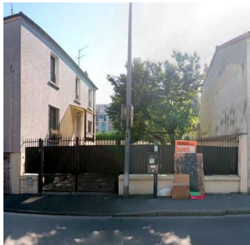
Vue de l'existant
