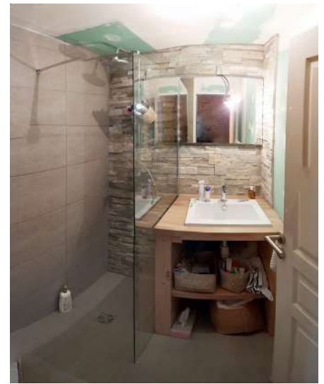
Vue de la salle de douche
