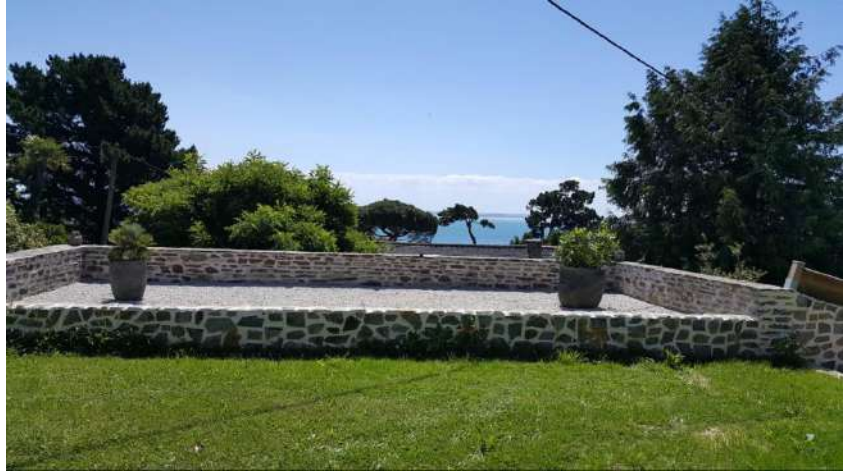
Vue vers la mer suite à réalisation
