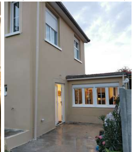
Vue de l'entrée et de la cuisine depuis le jardin
