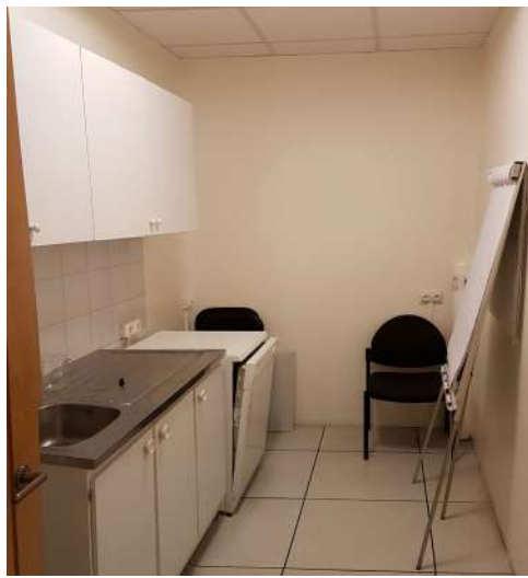
Vue de la kitchenette existante
