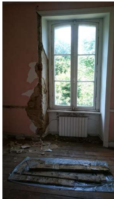
Vue de l'état existant en R+2
