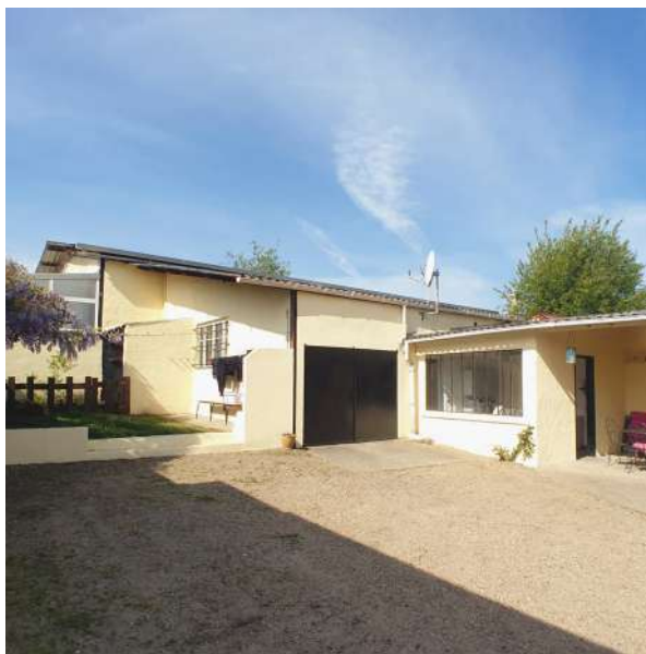
Vue de l'existant
