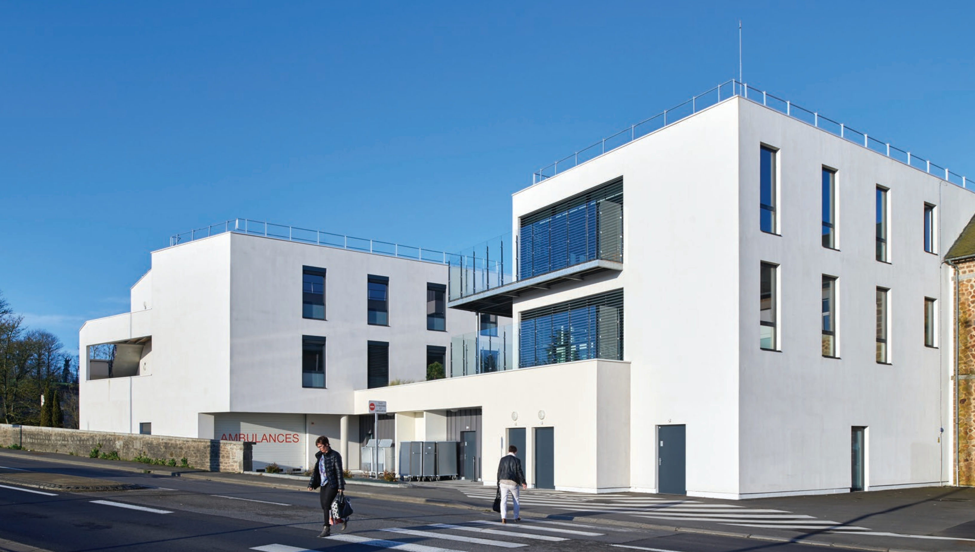
Façade Est - Accès ambulances
