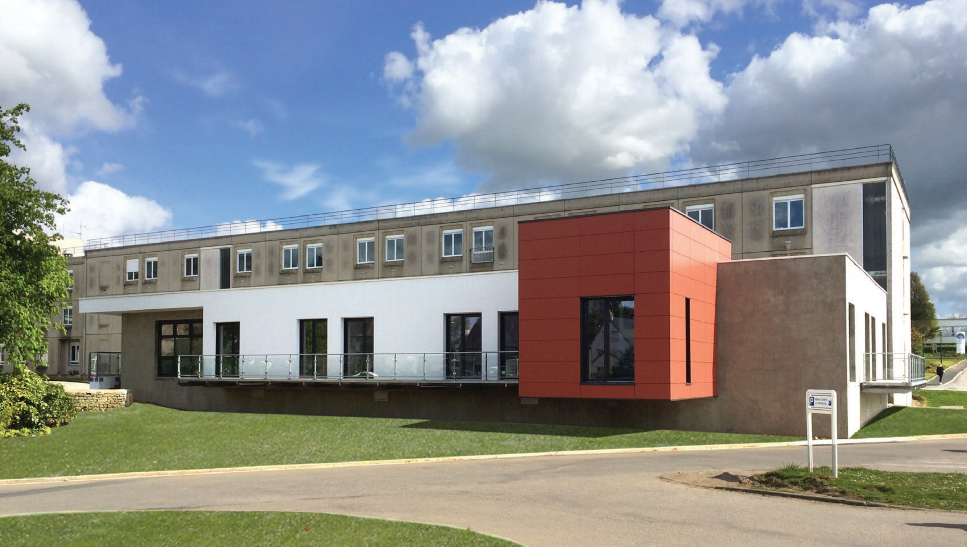
Vue générale de la façade Sud
