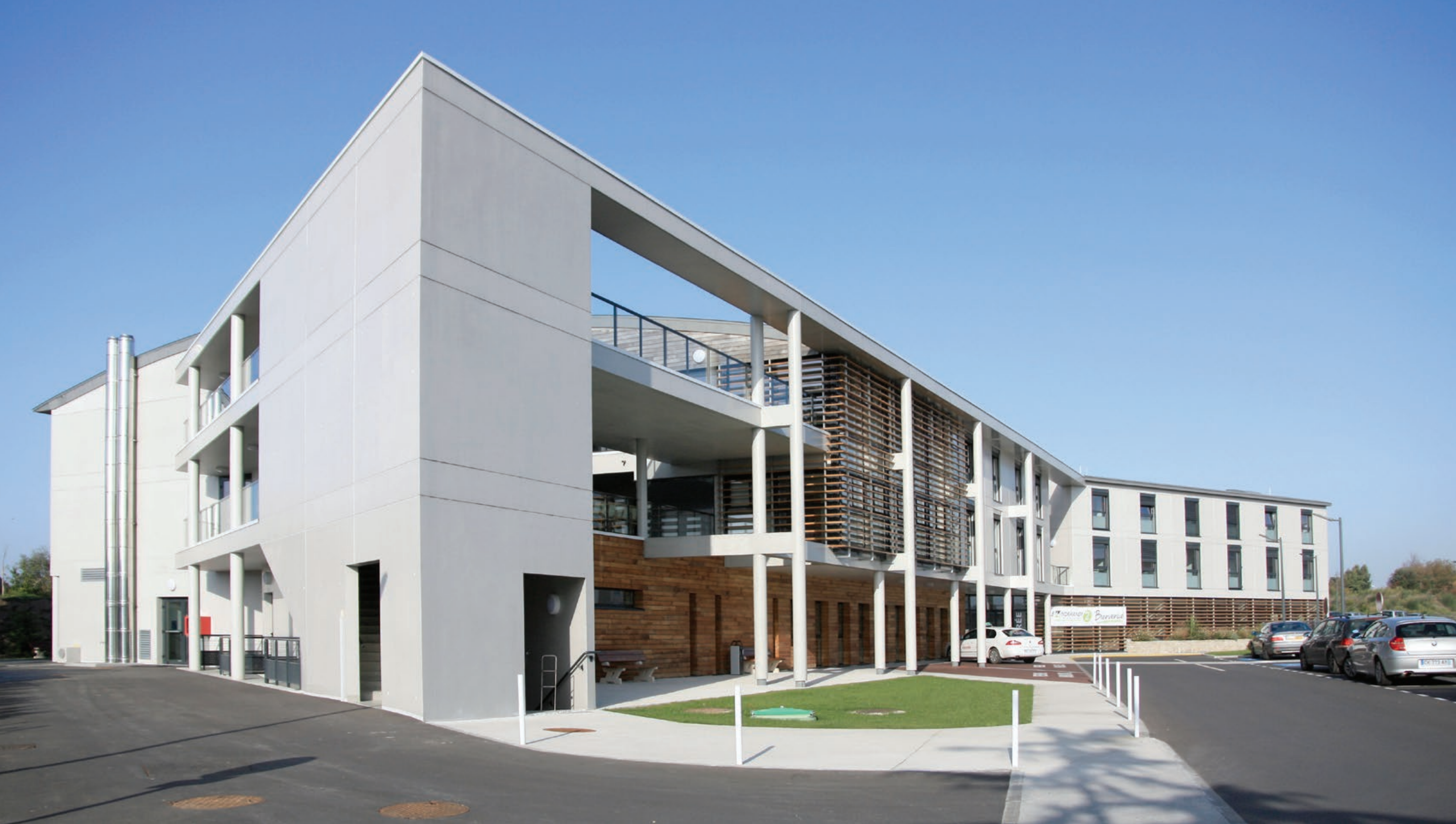
Vue de l'ensemble du bâtiment
