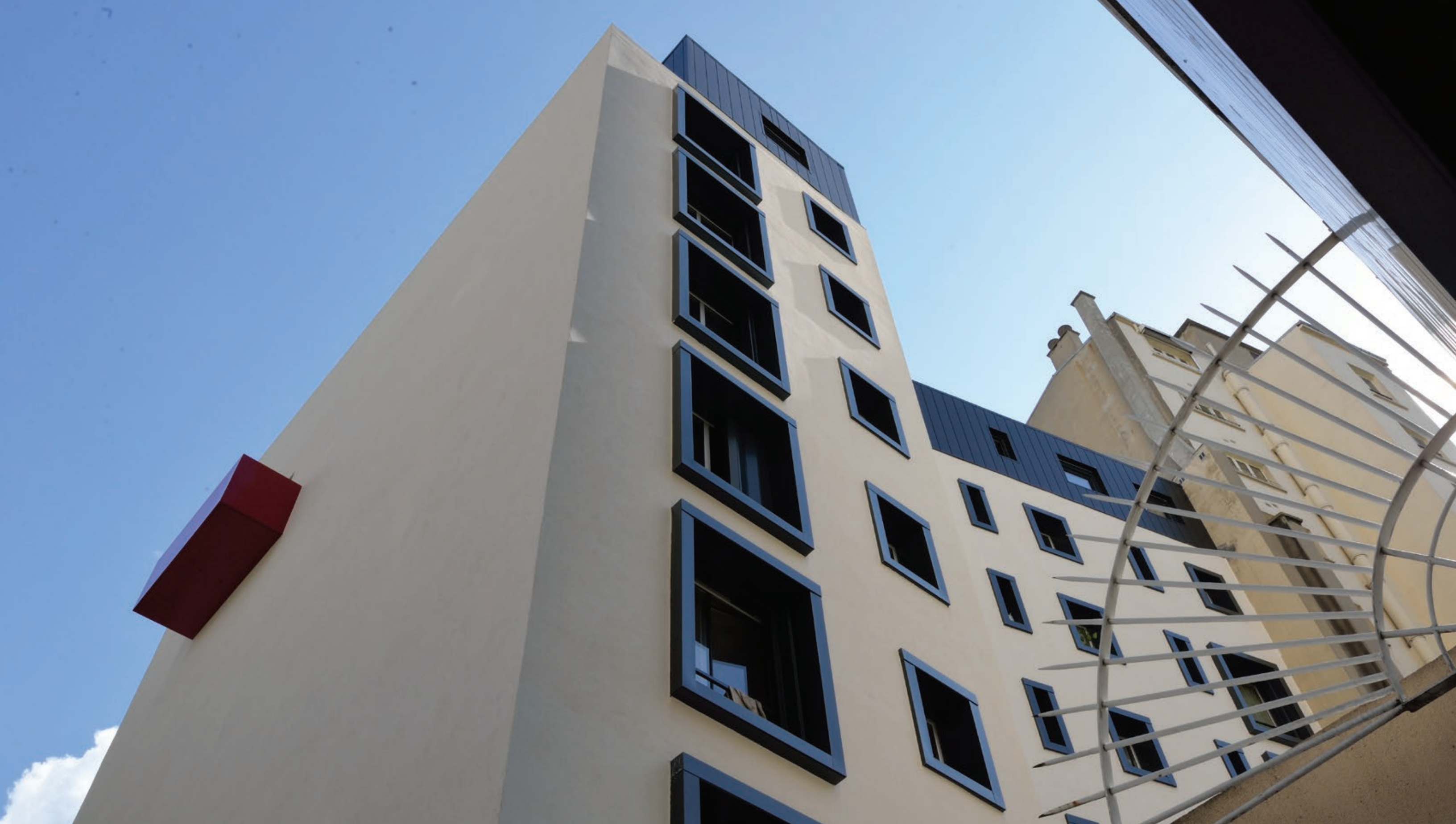
Façade Nord - Vue depuis le « cour Florent »
