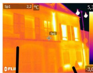
Maison client après rénovation
