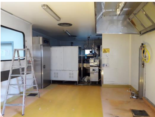
Phasage des intervention pour la cuisine dicté par la résine et son temps de séchage
