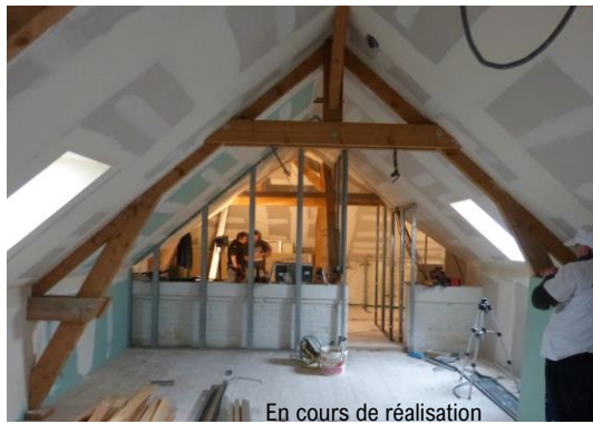
En cours de réalisation
