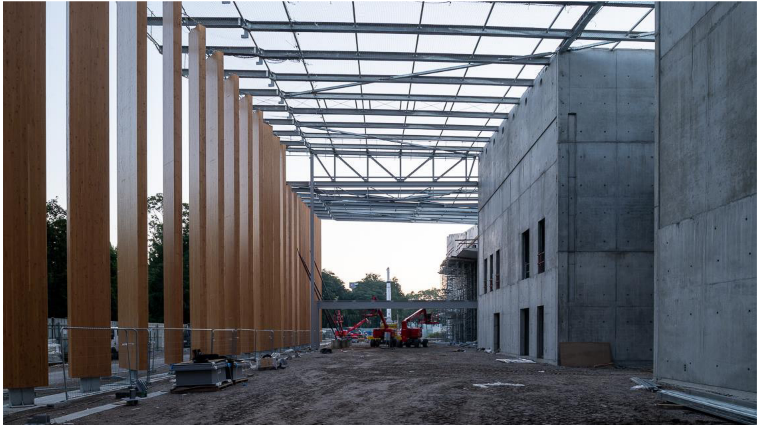
Vue du chantier (Septembre 2021)
