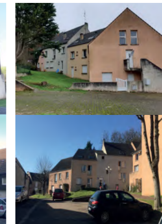
Photos avant travaux
