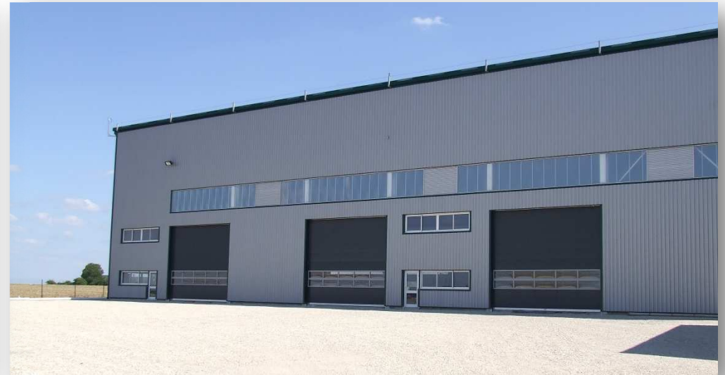
BATIMENT D'ACTIVITE AVEC TOIT EN PANNEAUX PHOTOVOLTAÏQUES
