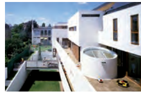
ÉTABLISSEMENT POLYVALENT DE LA PETITE ENFANCE À MAISONS-LAFFITTE, 1994 Rue de Mexico et Puebla, Maisons-Laffitte (78) Maîtrise d'ouvrage: ville de Maisons-Laffitte Surface: 2500 m 2 shon Coût des travaux: 2,97 M€ HT
