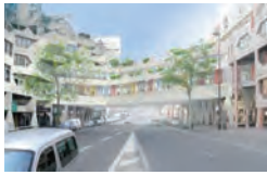
REVALORISATION DU CENTRE JEANNE HACHETTE À IVRY-SUR-SEINE, 2005 Maîtrise d'ouvrage: Sadev 94
