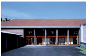
ÉCOLE ÉLÉMENTAIRE ALBERT CAMUS À RUEIL-MALMAISON, 2002 Rue Jean Édeline, Rueil-Malmaison (92) Maîtrise d'ouvrage : ville de Rueil-Malmaison Surface: 1971 m 2 shon Coût des travaux: 4,4 M€ HT
