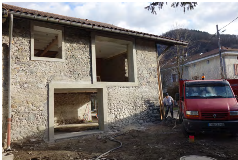
Aile Ouest _ Création des ouvertures du studio et de l'appartement
