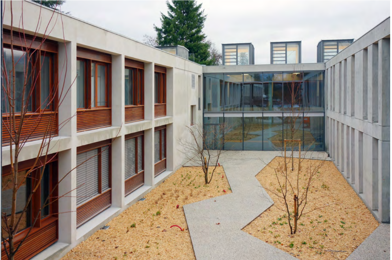
Photo du Patio Sud (batiment existant rénové à gauche et extension au fond et à droite)
