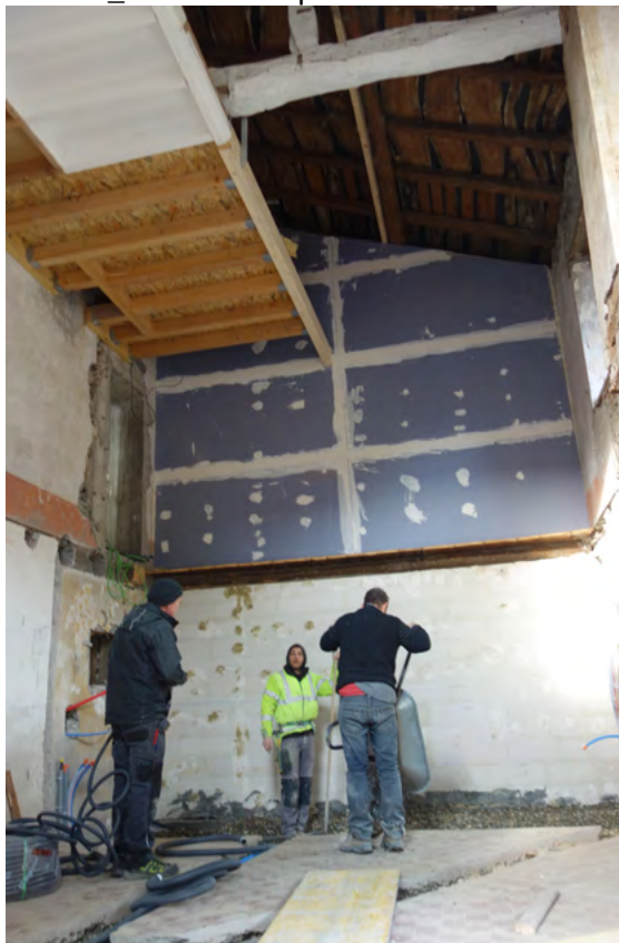
Aile Est _ réfection du plancher intermédiaire
