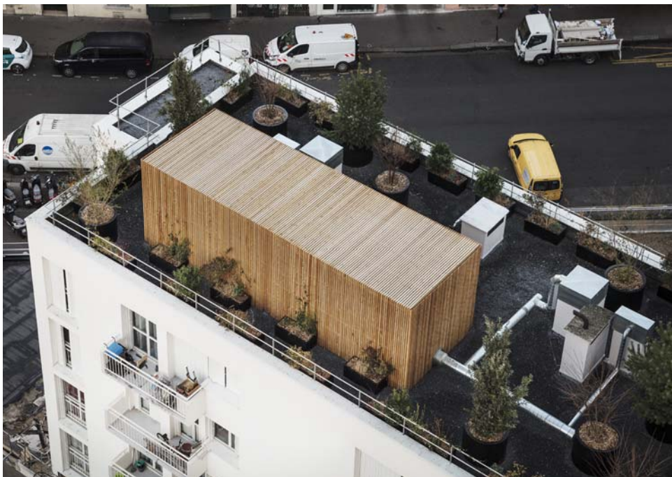
Vues depuis le bâtiment D des toitures T2 et G
