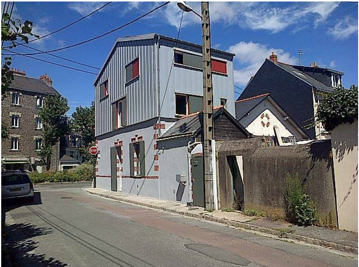
Nantes Maison Caillou après travaux Nantes
