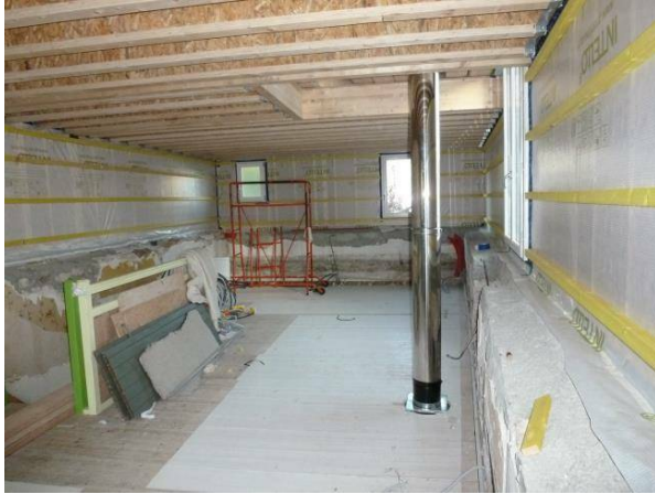
Maison Caillou travaux Nantes
