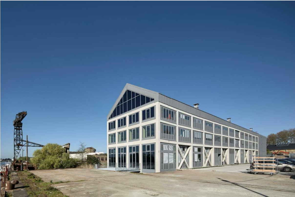
SCI Crucy Nantes après travaux
