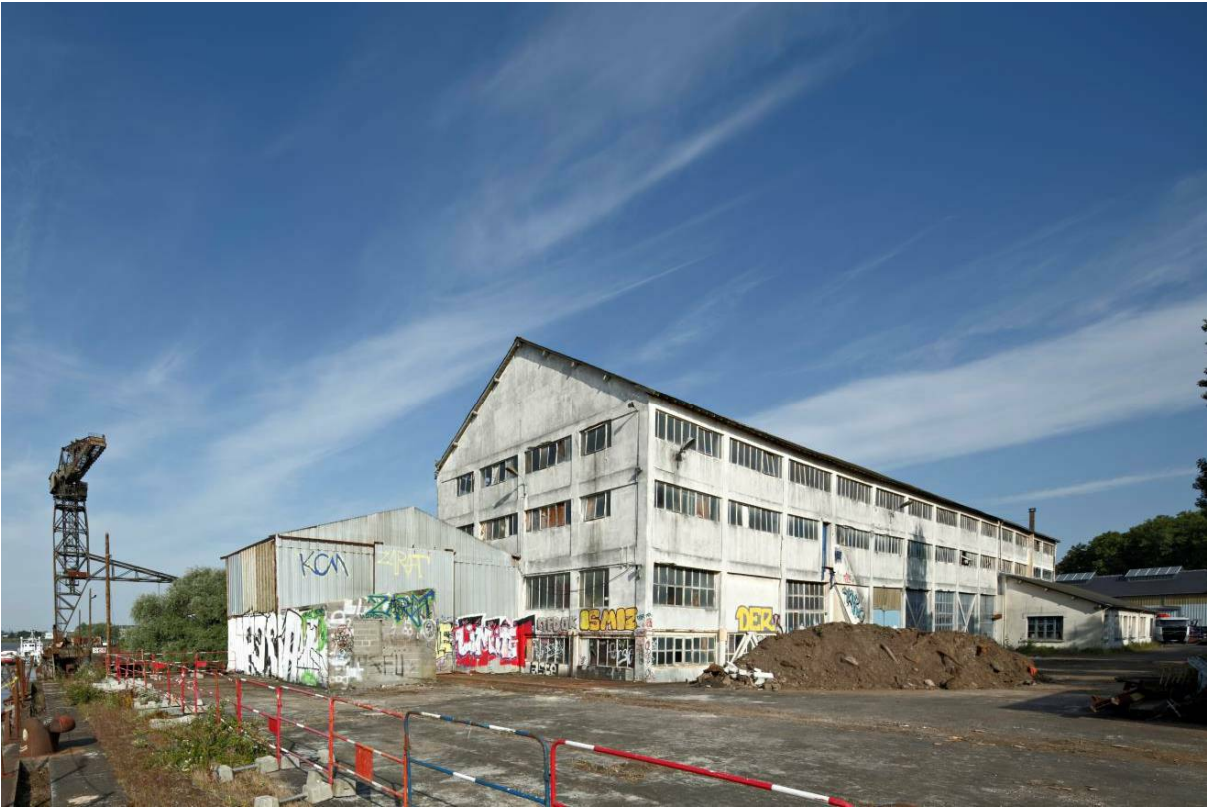
SCI Crucy Nantes avant travaux
