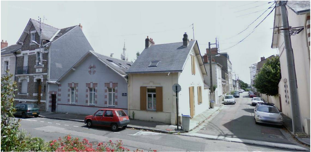
Maison Caillou avant travaux Nantes
