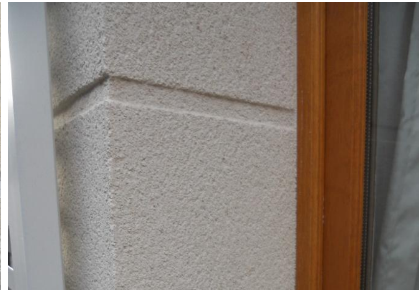
Différents essais de décapage de la peinture minérale sur plâtre (décapeur thermique, chalumeau et ponçage manuel) ; Application d'un enduit à la chaux par projection mécanique à basse pression et pose de mailles en néoprène sur ancrages métalliques, finition par grattage fin
