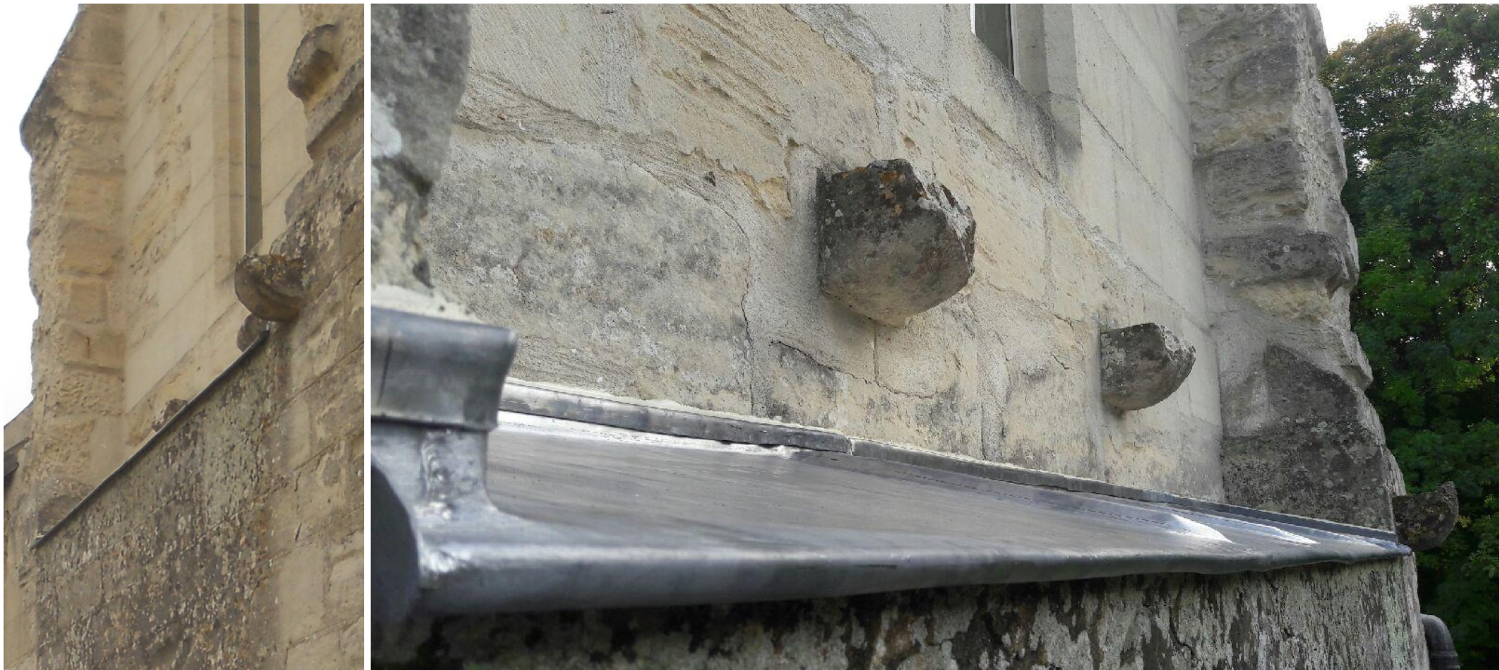
Détail du recouvrement des plaques sur tasseau arrondi et agrafé, et du larmier formant goutte d'eau avec ourlet de rive.
