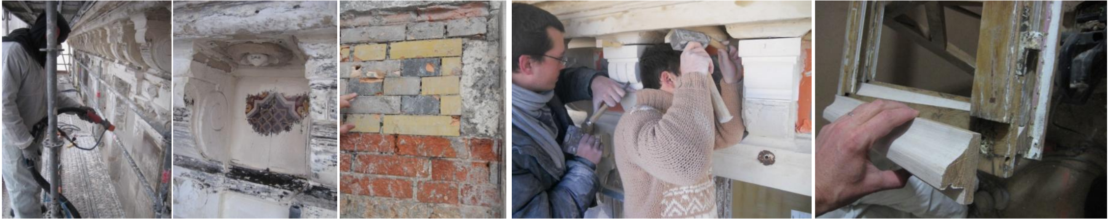
Hydro-gommage et mise à nu des parements anciens
