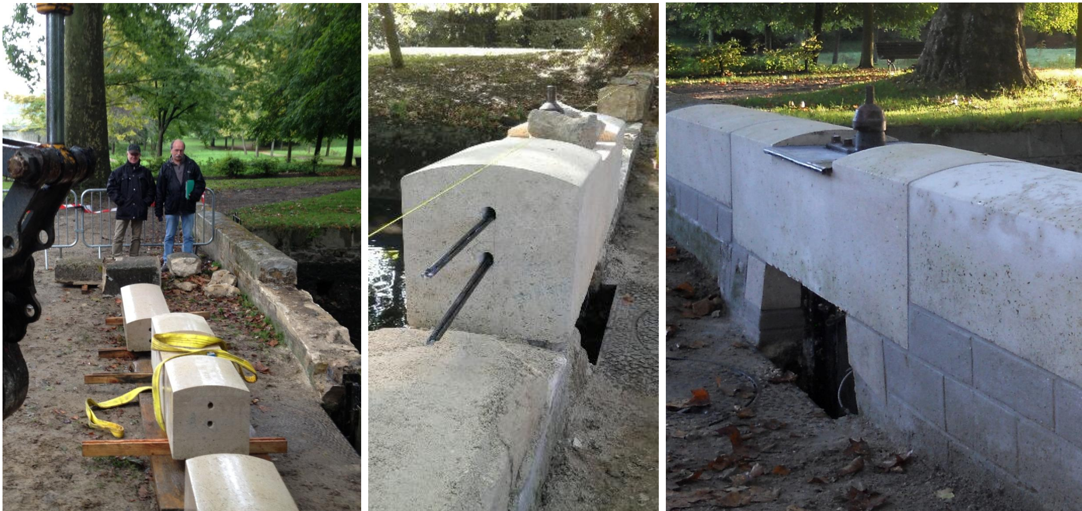
Présentations des blocs de pierre en pied d'ouvrage, pose d'armatures en fibre de carbone scellées à la résine liquide, rejointoiement au mortier de chaux hydraulique
