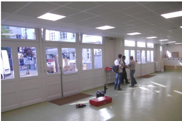
Travaux de doublage en placostil pour création de placard encastrés et faux-plafonds acoustiques, avec ouvrages électricité (dalles led) et plomberie ; pose de nouvelles menuiseries extérieures en bois
