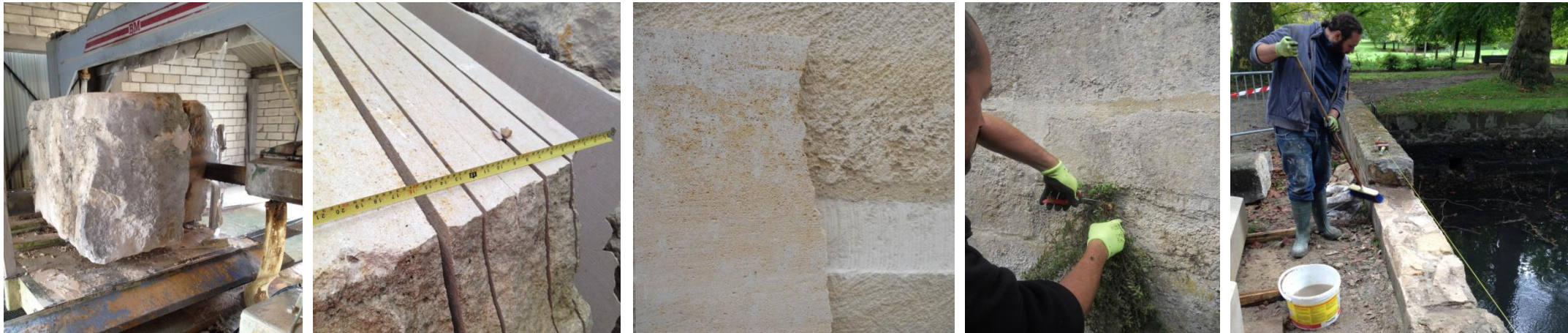
Préparation en carrière des échantillons des blocs de pierre de taille et validation in situ, travaux de nettoyage par taille du lierre au sécateur et brossage manuels
