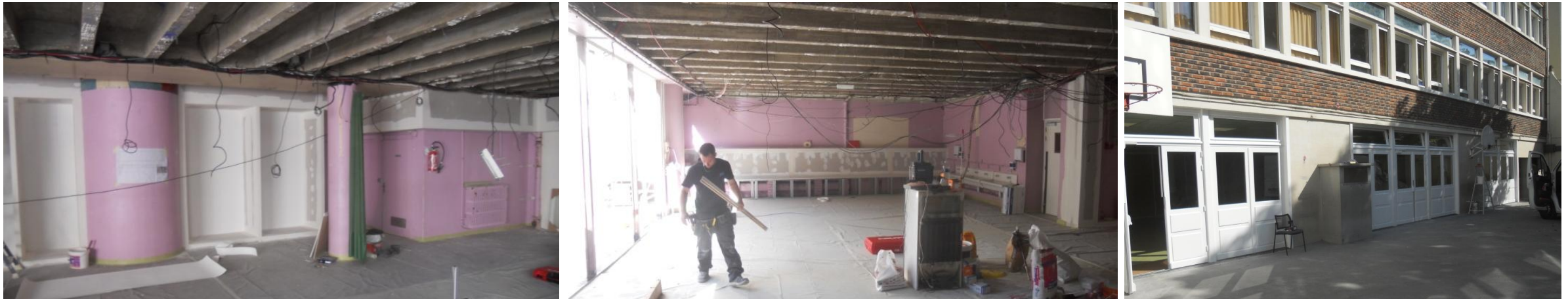
Travaux de doublage en placostil pour création de placard encastrés et faux-plafonds acoustiques, avec ouvrages électricité (dalles led) et plomberie ; pose de nouvelles menuiseries extérieures en bois
