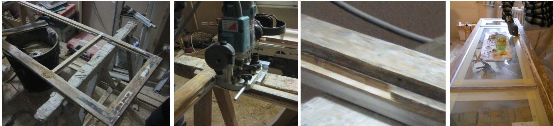
Dépose des battants des menuiseries pour décapage, élargissement des feuillures pour pose vitrage épais acoustique et thermique, masticage avant peinture
