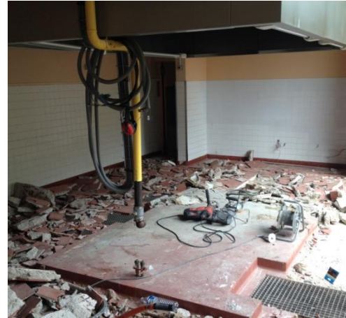
Dépose des équipements et du matériel existants, réfection d'une chape avec ravaillage technique, pose des doublages et des revêtements avec ouvrages électricité et plomberie noyés
