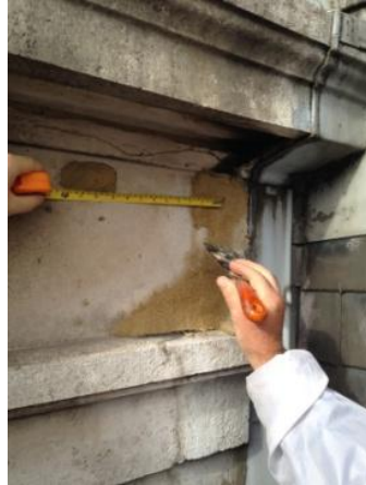
Essais de nettoyage par savon nettoyant et cataplasme d'argile
