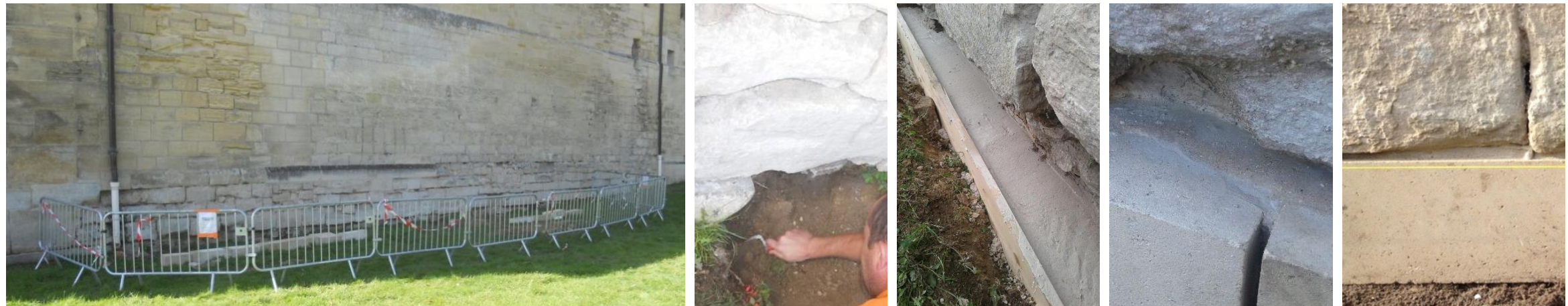
Présentation des blocs en pied d'œuvre, fouille manuelle du lit d'arase de fondation, régénération de la furrure en mortier de chaux avec taille trapézoïdale des blocs neufs noyées, fond de joint
