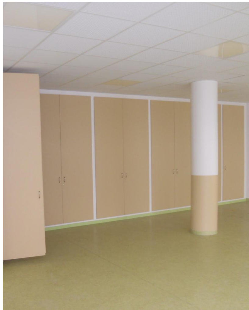
Travaux de doublage en placostil pour création de placard encastrés et faux-plafonds acoustiques, avec ouvrages électricité (dalles led) et plomberie ; pose de nouvelles menuiseries extérieures en bois
