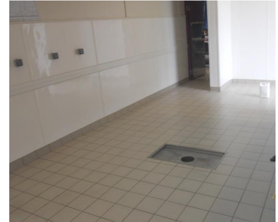
Dépose des équipements et du matériel existants, réfection d'une chape avec ravaillage technique, pose des doublages et des revêtements avec ouvrages électricité et plomberie noyés
