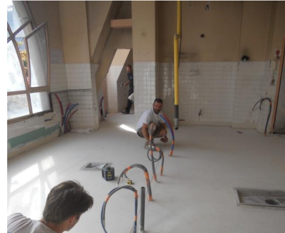
Dépose des équipements et du matériel existants, réfection d'une chape avec ravaillage technique, pose des doublages et des revêtements avec ouvrages électricité et plomberie noyés
