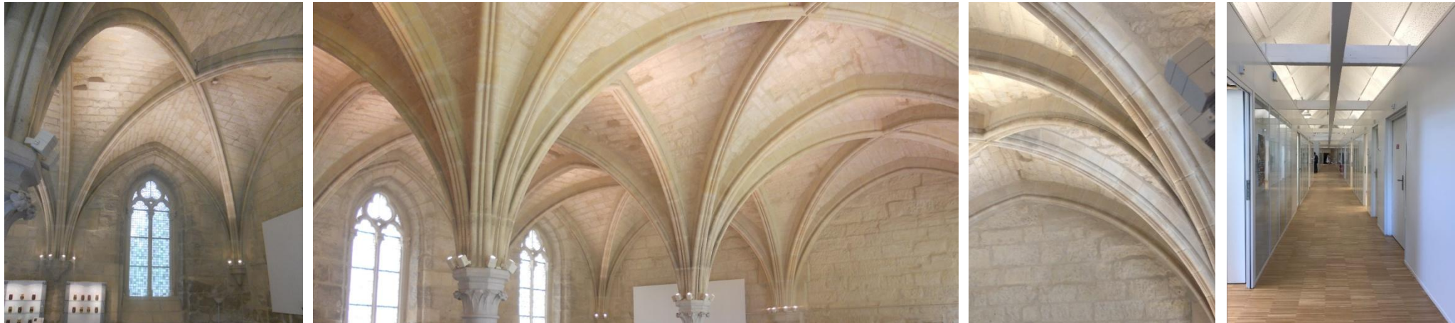
Remplacement de l'éclairage des salles voûtées en croisée d'ogives en rez-de-chaussée et à l'étage ; aménagement de bureaux à l'étage, sous les combles
