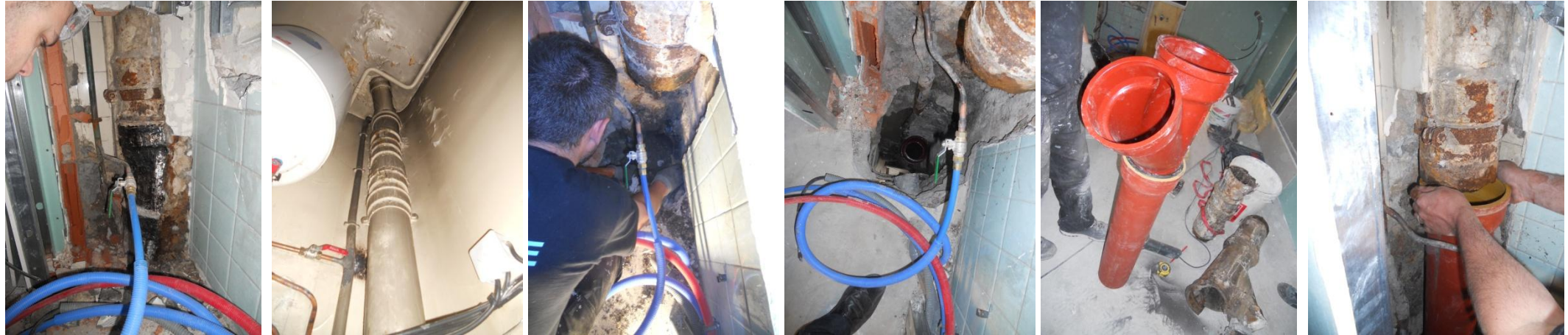
Travaux de plomberie pour la réparation d'un dégât des eaux sur une colonne existante EU/EV en fonte
