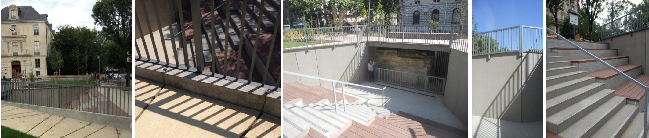
Fouilles et protections des vestiges archéologiques en créant un espace de gradins en béton et résine de bois : mise en œuvre d'une allée centrale en résine de bois, d'une passerelle en charpente métal et platelage en résine de bois, de murs de soutènement en BA préfabriqués et coulés in situ.
