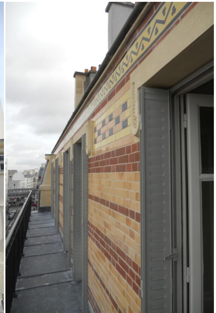
Détail du parement en brique et carreaux-céramique
