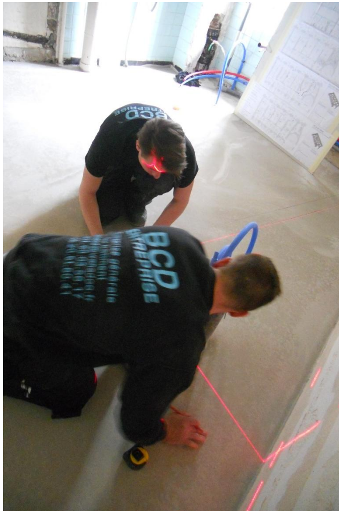
Traçage de cloisons et doublage en placostil de l'espace kitchenette/sanitaires avec isolation acoustique et chasse d'eau intégrée 8 cm pour wc suspendu
