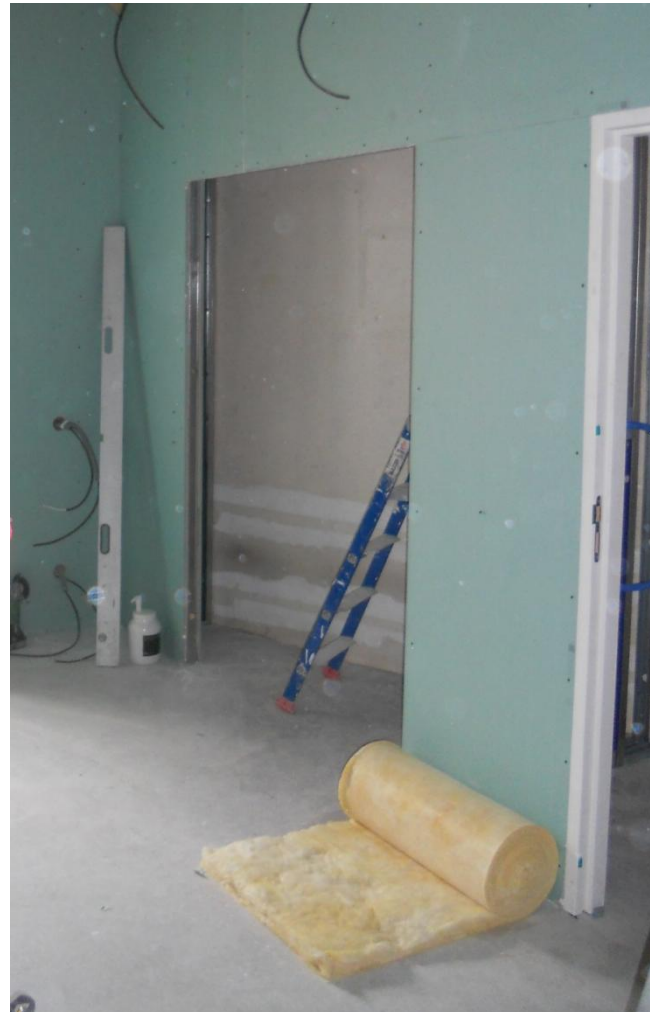
Traçage de cloisons et doublage en placostil de l'espace kitchenette/sanitaires avec isolation acoustique et chasse d'eau intégrée 8 cm pour wc suspendu
