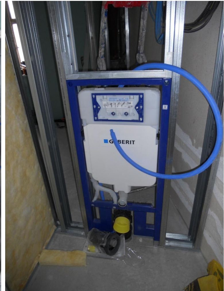
Traçage de cloisons et doublage en placostil de l'espace kitchenette/sanitaires avec isolation acoustique et chasse d'eau intégrée 8 cm pour wc suspendu
