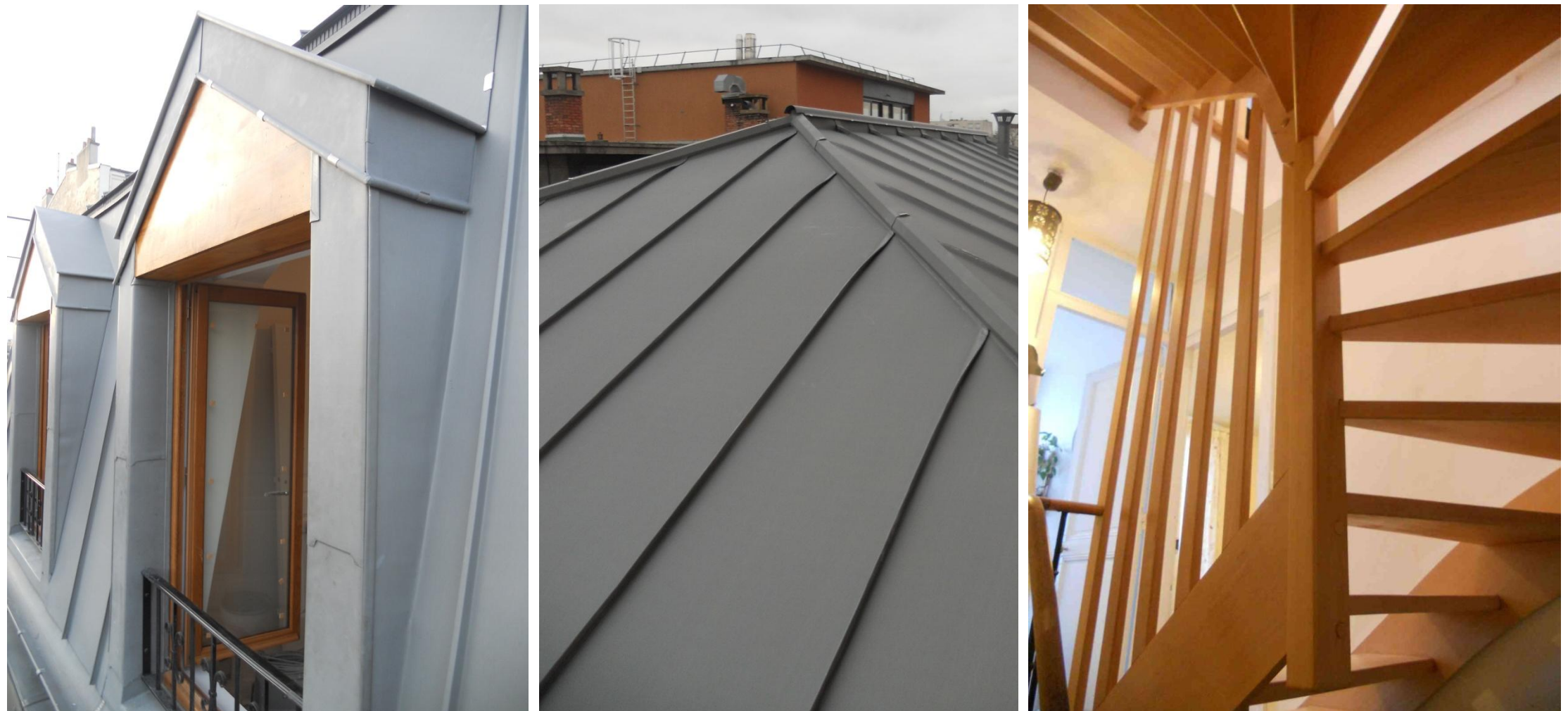
Vues de détail et de finition des lucarnes avec fenêtres et linteaux en chêne, terrassons à joints débout et escalier en bois de hêtre
