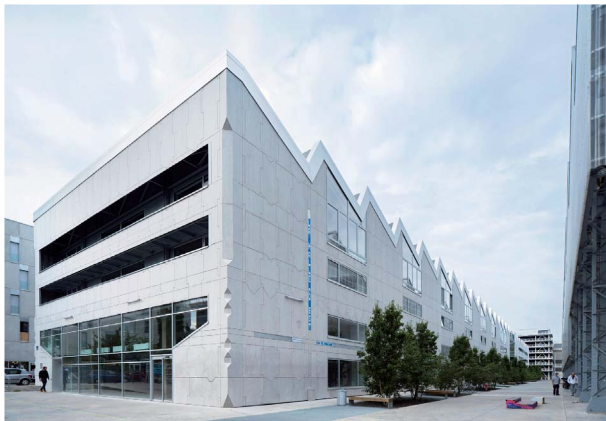
Façade Nord Est
