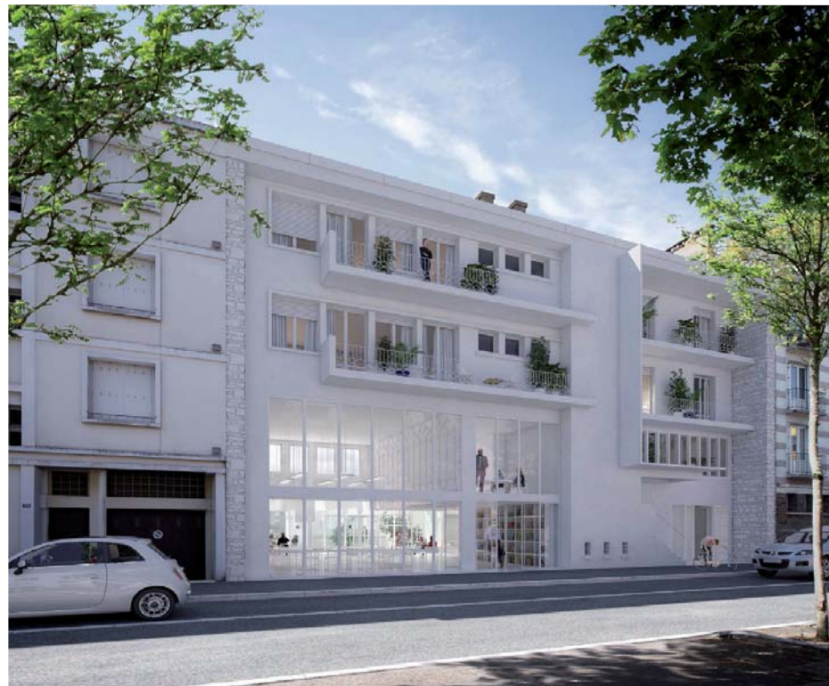
Vue de l'entrée principale _rue albert de Mun
