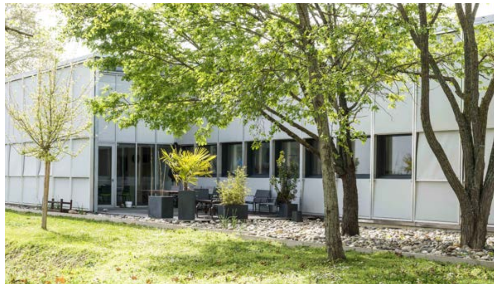
CRGS (construction neuve en bois) livraison 2014
