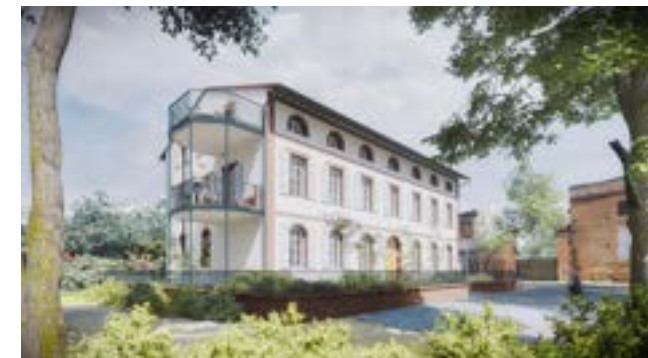
LOGEMENTS, LA MAGANNERIE - POMPERTUZAT (31)
