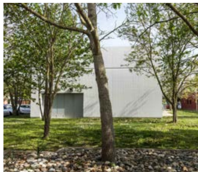
DATA Center (construction neuve) livraison 2014
