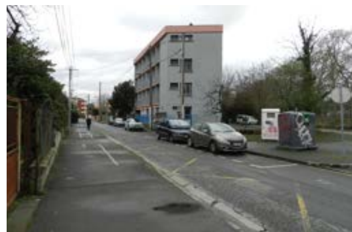
BÂTIMENT PRINCIPAL À DECONSTRUIRE
