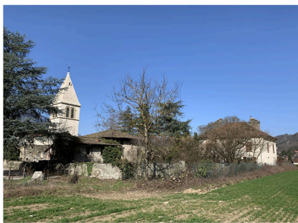
Réhabilitation du clos du Cheylas
