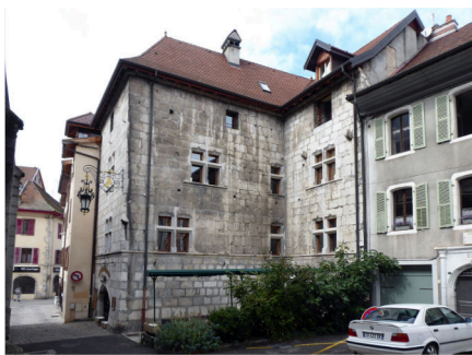
Restauration de la Maison de l'alchimiste (IMH)
