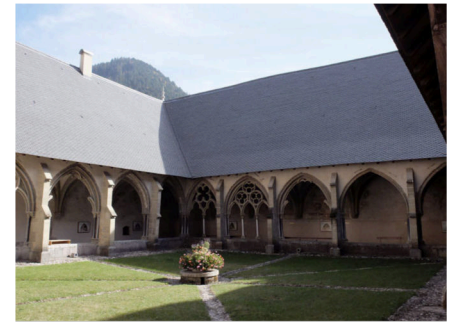
Restructuration de l'abbaye d'Abondance (MH) et de la maison du Val
