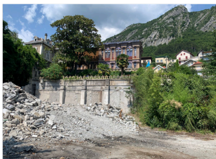
Restauration du mur de soutènement ouest de la Casamaures (CMH)
