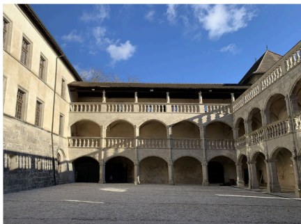
Restauration du mur de soutènement ouest de l'esplanade du château de Clermont-en-Genevois (I-CMH)
