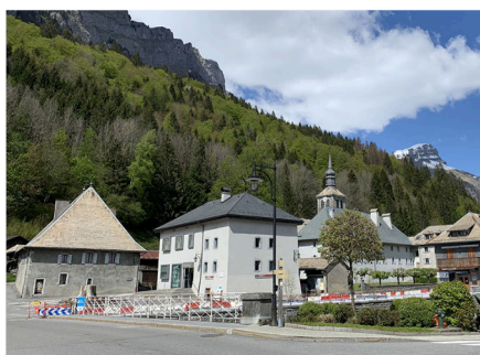
Restauration de l'enceinte sud du logis abbatial, ancienne abbaye de Sixt-Fer-à-Cheval (IMH)
