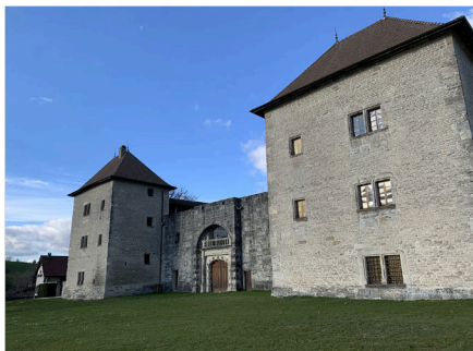
Restauration du château de Clermont (I-CMH)
