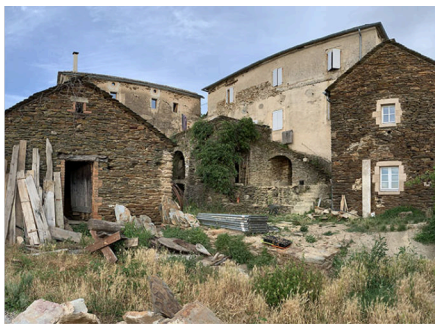
Réhabilitation du Clos des Fourniels
