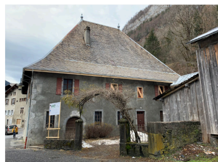
Réhabilitation du presbytère, ancienne abbaye de Sixt-Fer-à-Cheval (IMH)
