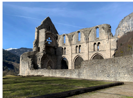
Restauration des vestiges de l'église de l'ancienne abbaye d'Aulps (CMH)
