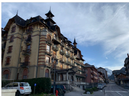
Restauration des toitures et façades de l'ancien hôtel du Mont-Joly (IMH)
