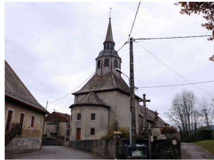
Restauration de l'église Saint-Pierre (MH)
