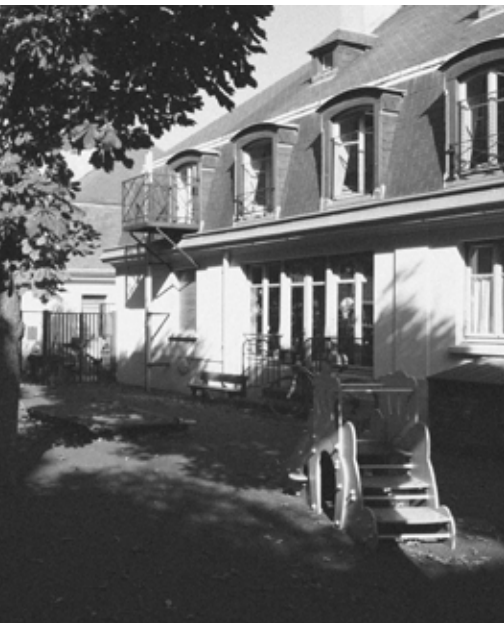
REHABILITATION / Etat existant
