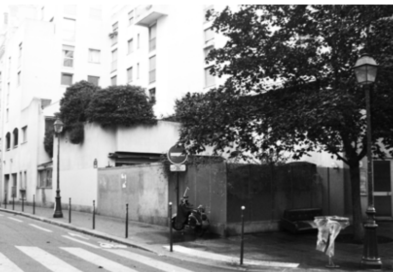
REHABILITATION / Etat existant
