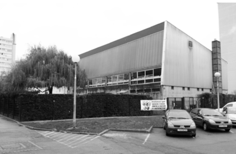
REHABILITATION / Etat existant
