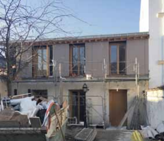
Etat antérieur le bardage en cours de pose (nov.2020) Etat Projeté
