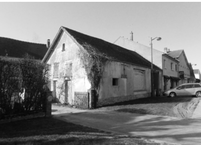
REHABILITATION / Etat existant
