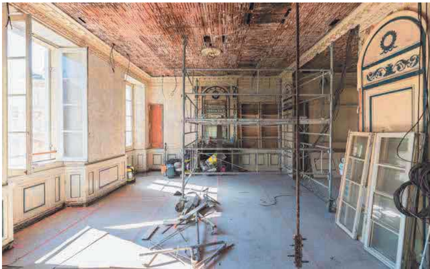
Pièce de vie // Photographies // en travaux
