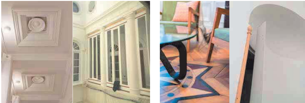
Détails : faux-plafond-menuiseries-parquets - porte courbe
