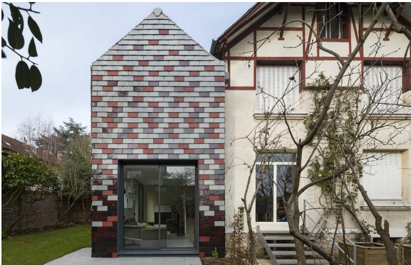
Façade Sud de l'extension en tuile émaillée + Maison existante dont l'intérieur a été rénové
