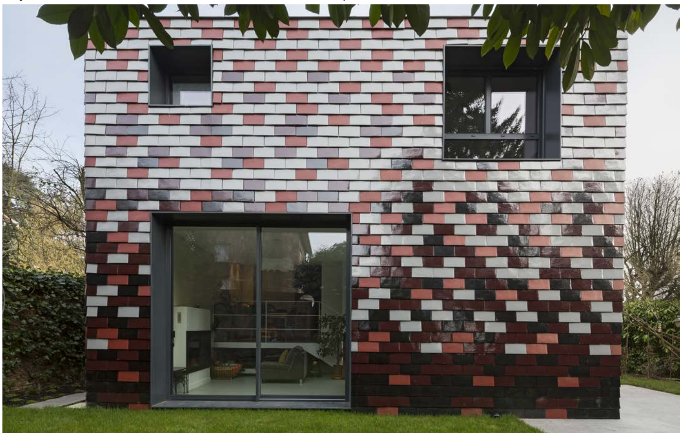
Façade Ouest de l'extension en tuile émaillée côté fond de parcelle
