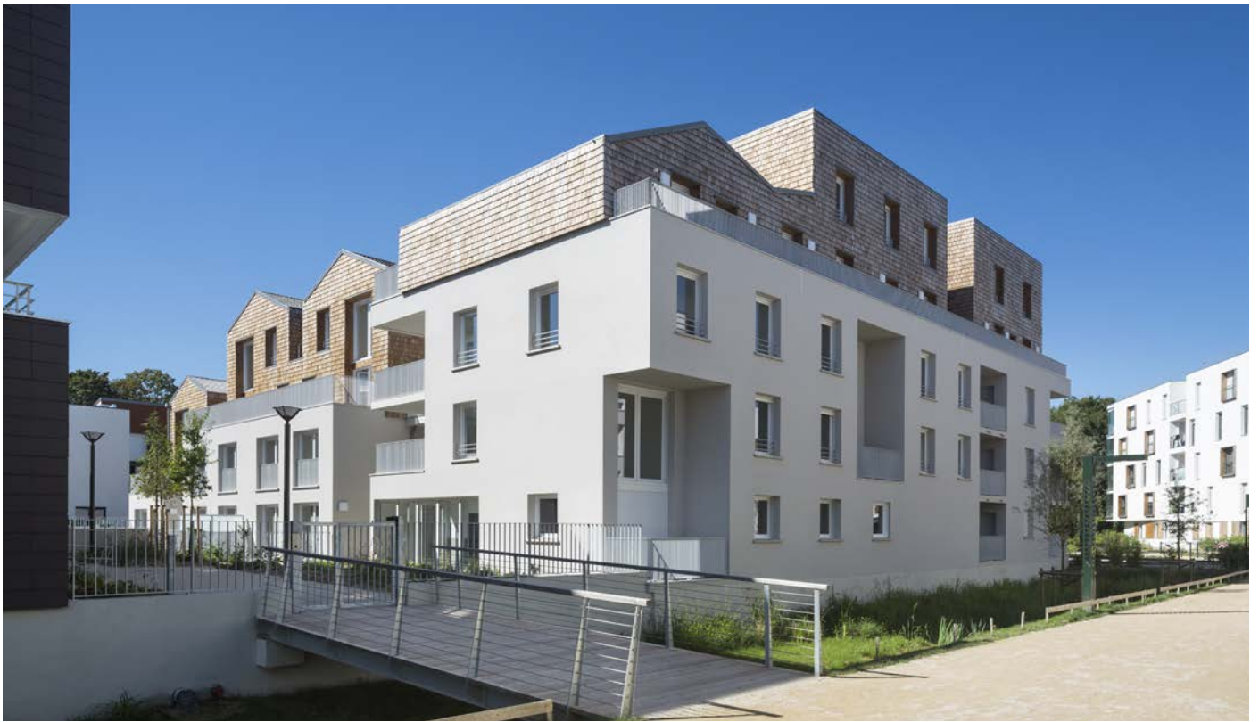
Angle du bâtiment vu du côté de la noue végétalisée (inondable) et de la promenade piétonne
