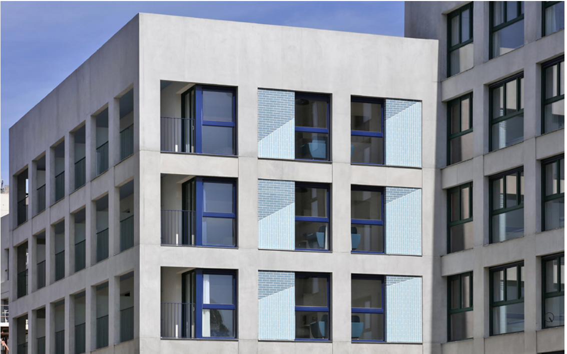
Vue depuis le coeur d'îlot : angle sud | Photographie de Filip Dujardin | View from the courtyard: south angle | Photography by Filip Dujardin
