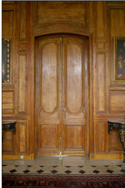
Restauration des boiseries du vestibule
