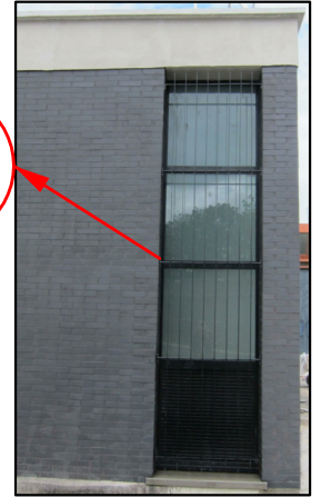
Détail des fenêtres
