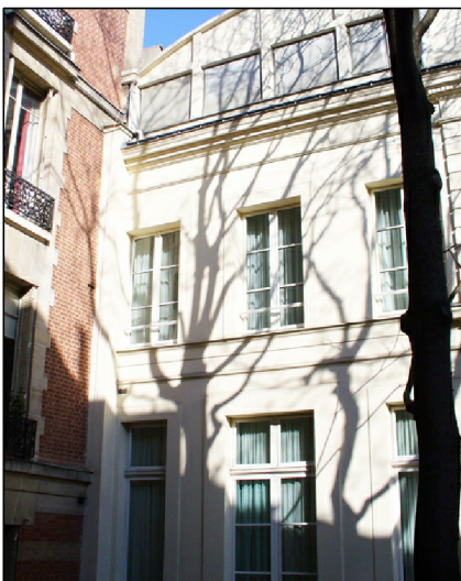
Photos du ravalement de la façade avec reconstitution de la corniche après travaux réalisés
