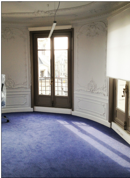
Bureaux après travaux réalisés
