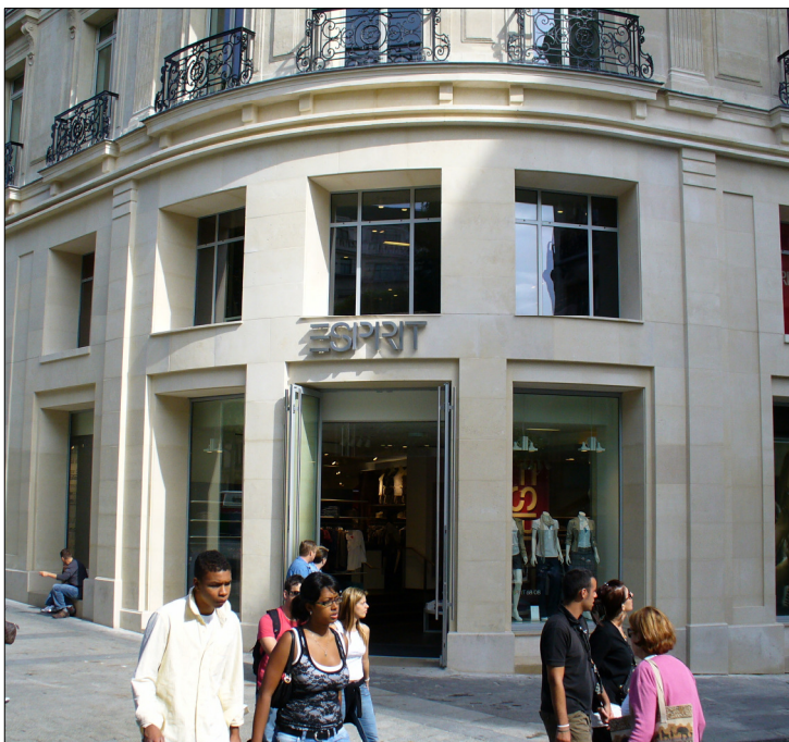
Photos de la boutique après travaux réalisés
