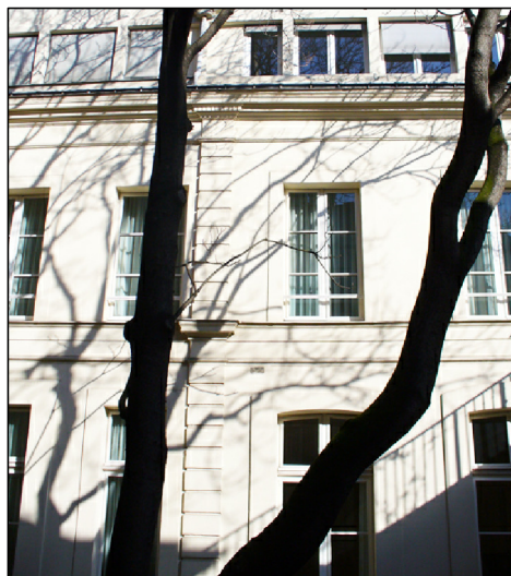
Photos du ravalement de la façade avec reconstitution de la corniche après travaux réalisés
