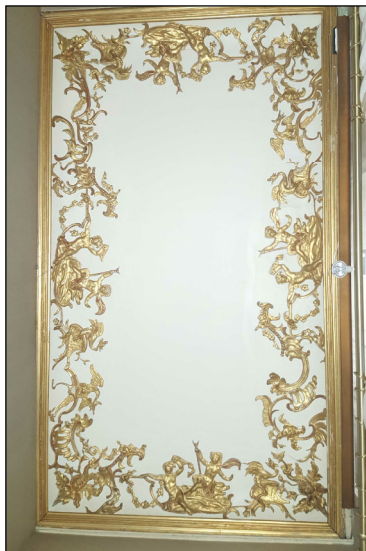
Plafond de l'alcove du boudoir restauration des décors sculptés et dorures
