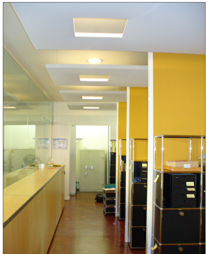
Photo des panneaux acoustiques dans les guichets pour visas après travaux réalisés
