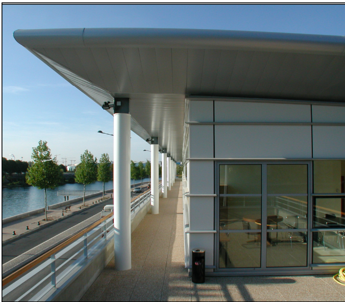
Vues des façades extérieures
