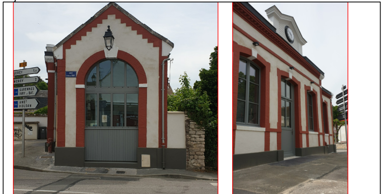
Pignon et façade principale ravalés
