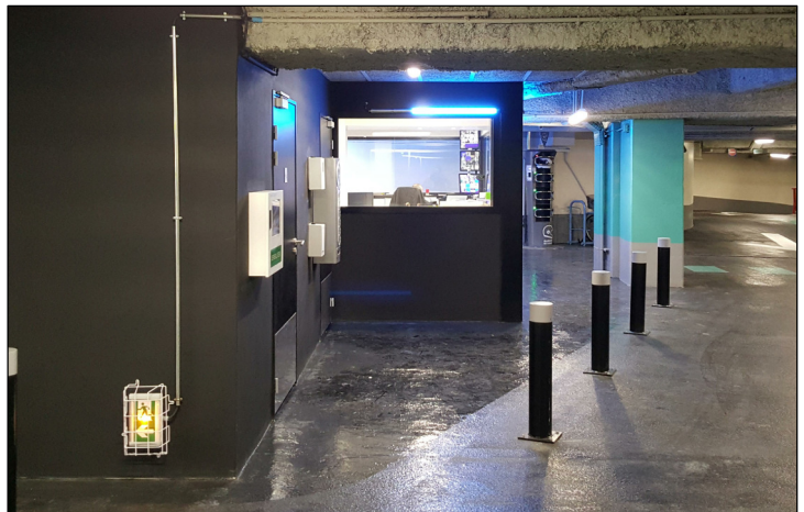
Local d'exploitation après travaux réalisés
