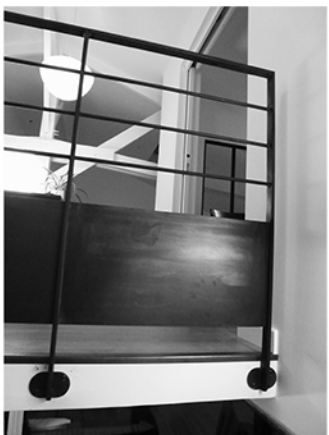
VUE SUR LE GARDE-CORPS
