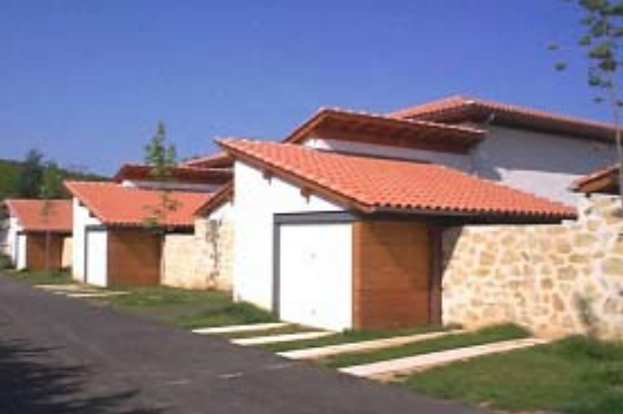
Jean-Luc Rames - Architecte dplg - Résidence Le Payrat Cahors (46).
