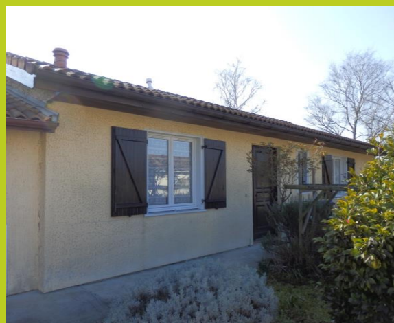
Photo 1: Logement avant rénovation
