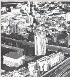
Tour Poissonniers, bâtiment de Raymond Lopez (1958)
