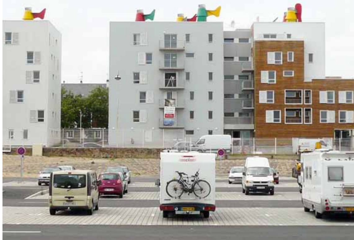
À Saint-Nazaire, le Parc Delzieu est un ensemble de 95 logements collectifs sociaux et en accession, répartis dans cinq immeubles livrés entre 2011 et 2012. Le système de ventilation naturelle assistée et contrôlée (VNAC), développé par l'atelier philippe madec et le BET Tribu, a nécessité l'obtention d'une ATEx.
