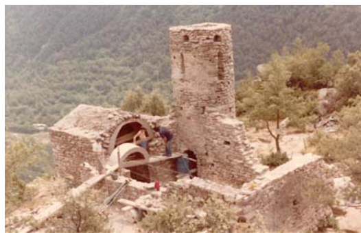
Figure. 3. Vue de l'église durant sa reconstruction
