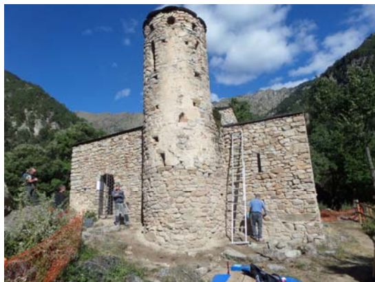
Figure. 4. Vue du clocher pendant les travaux d'entretien de 2016.
