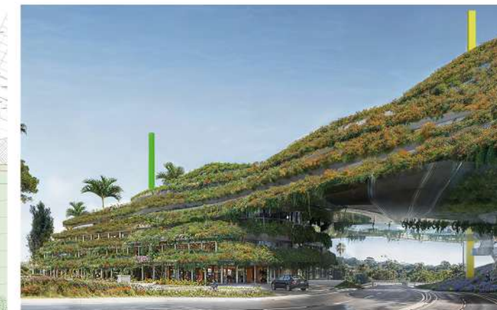
Vue du bâtiment depuis l'ouest
