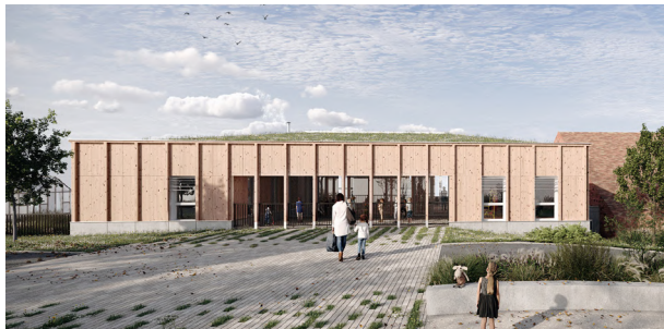
Rénovation d'une Salle d'Accueil Communale & Construction d'un Périscolaire 1200m 2 3,2M€
