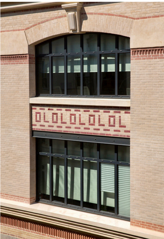
Détail de la façade sur cour
