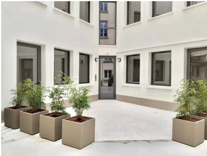
Photos projet réalisé
