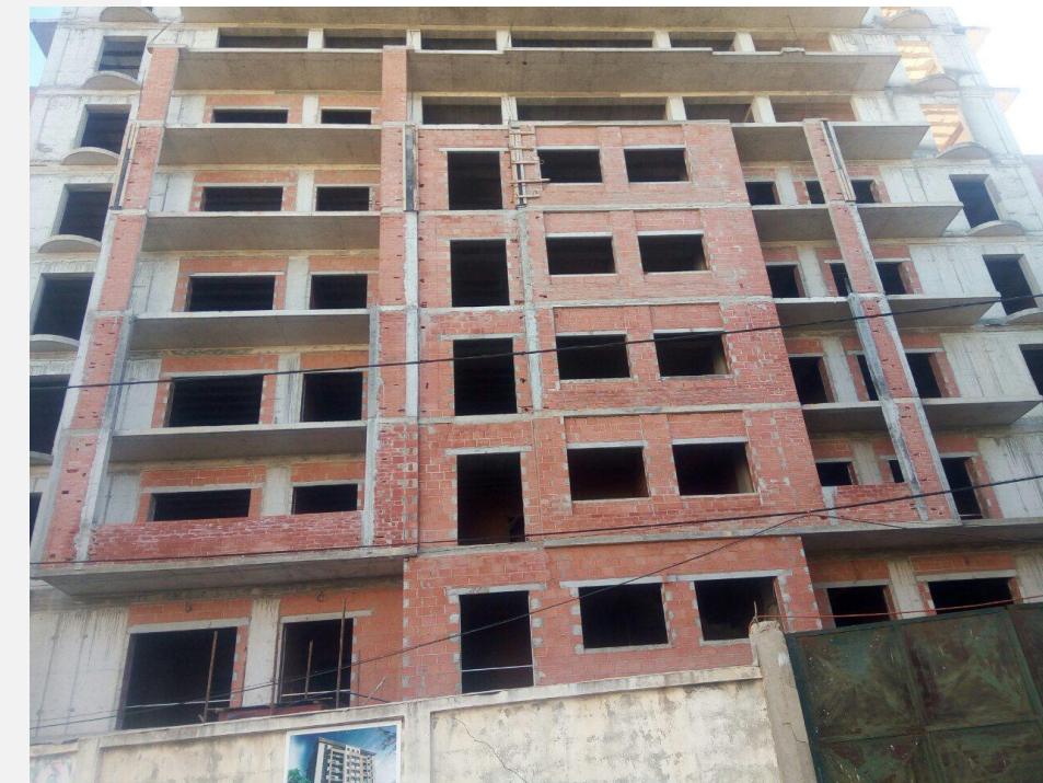
Chantier – Façade principale
