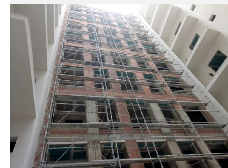
Chantier- Façade patio
