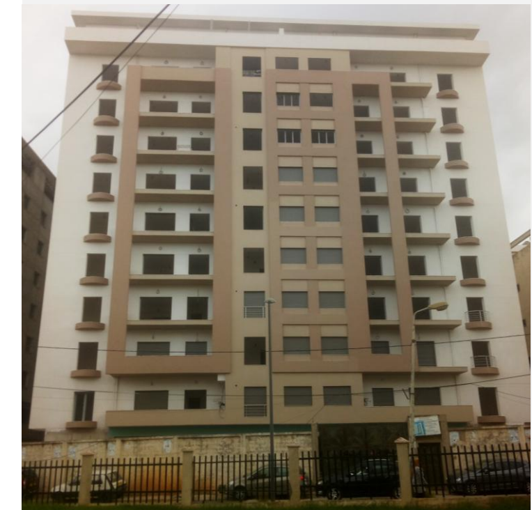
Chantier - Façade principale
