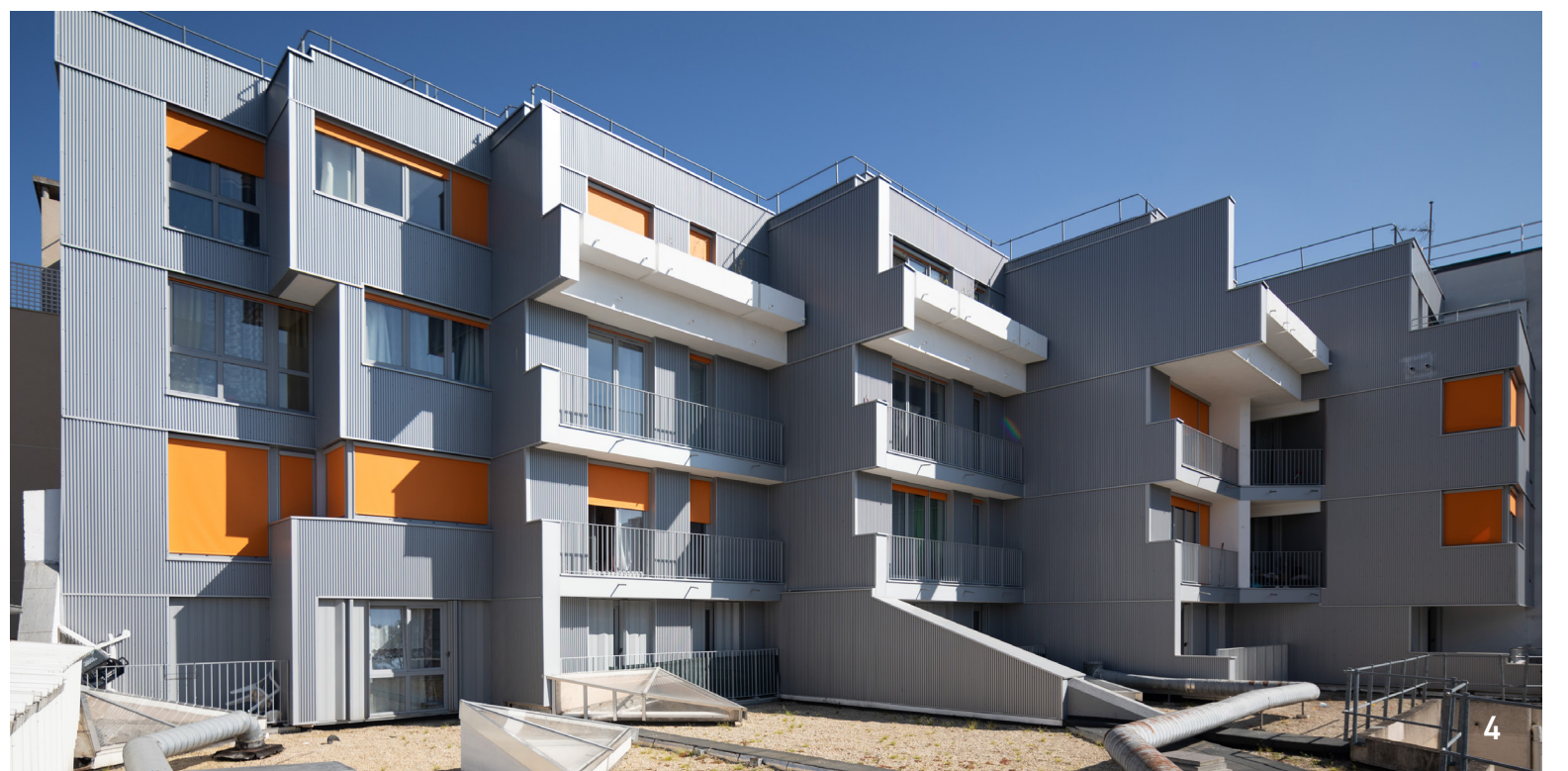
1-2 : Photos de l'état existant / 3-4 : Photos chantier
