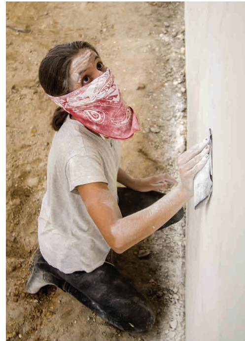
Les murs sont montés en parpaings puis enduits puis peints.
