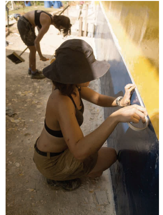
Les murs sont montés en parpaings puis enduits puis peints.
