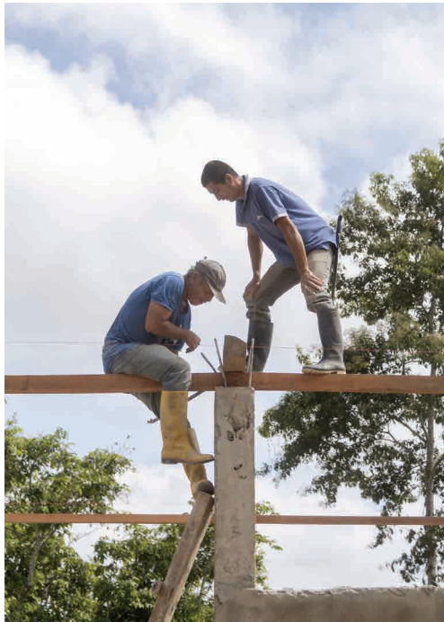
Des poteaux coulés en béton supportent une charpente en bois local.
