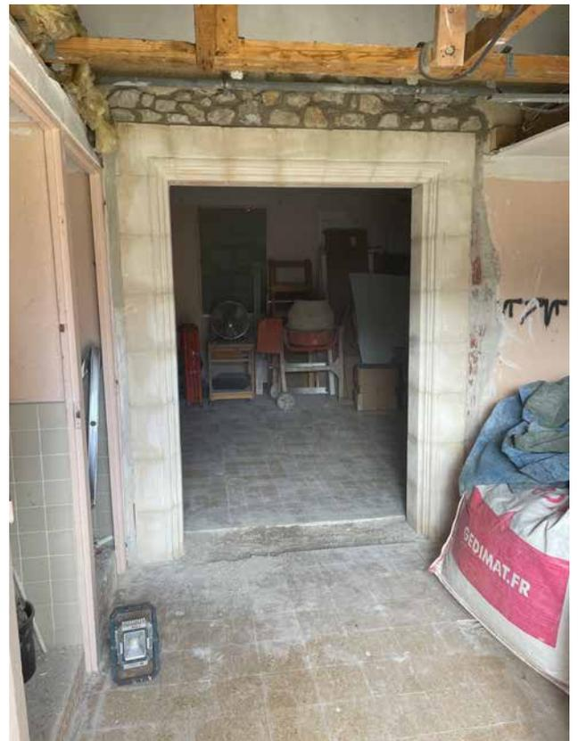
▲ Création d'une ouverture en sous-oeuvre et pose d'un encadrement de porte en pierre de taille
