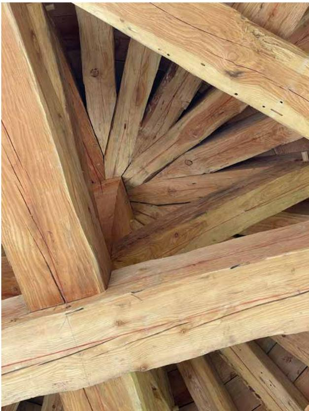
▲ Montage à blanc de la charpente et contrôle des assemblages
