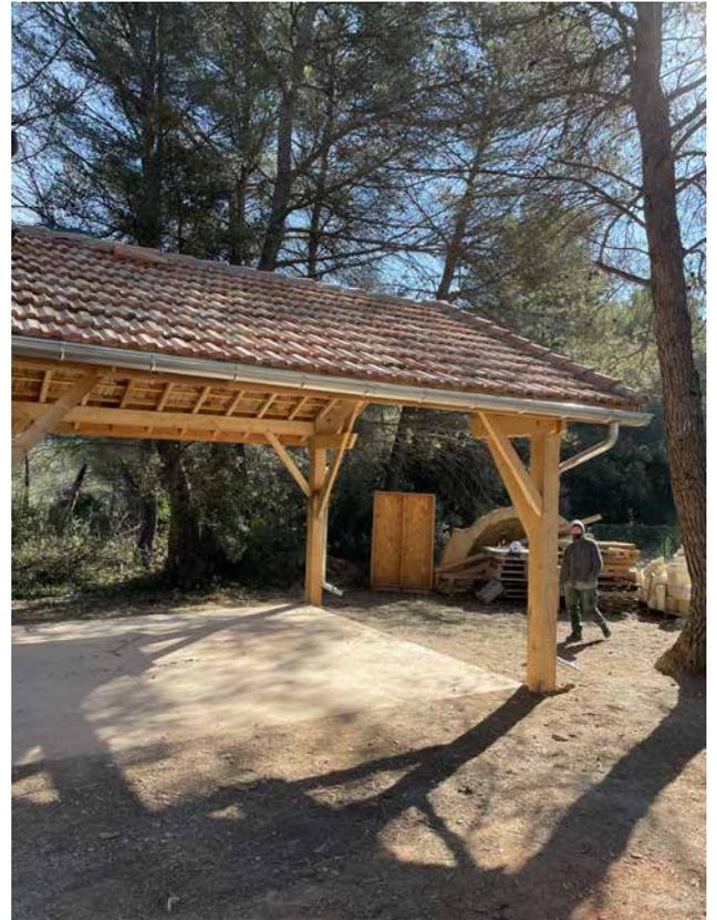
▲ Pose d'une couverture en tuiles mécaniques avec rives et faitage maçonnées, soudage de la zinguerie
