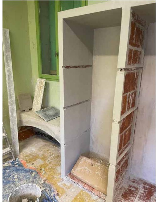
▲ Construction d'assise et de casiers en brique et plâtre
