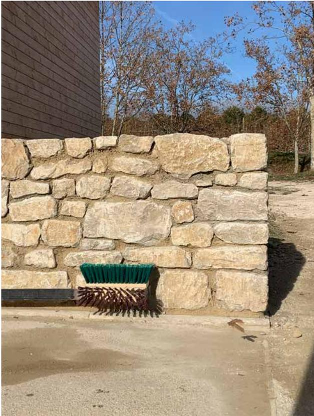
▲ Construction d'un mur en moellons maçonné à la chaux
