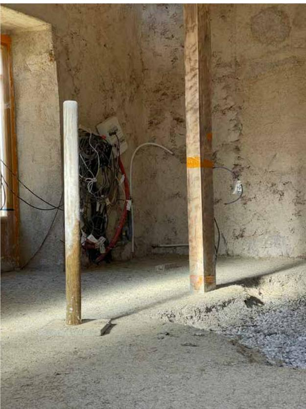
▲ Mise en place d'une dalle isolante chaux/fibres sur empierreage
