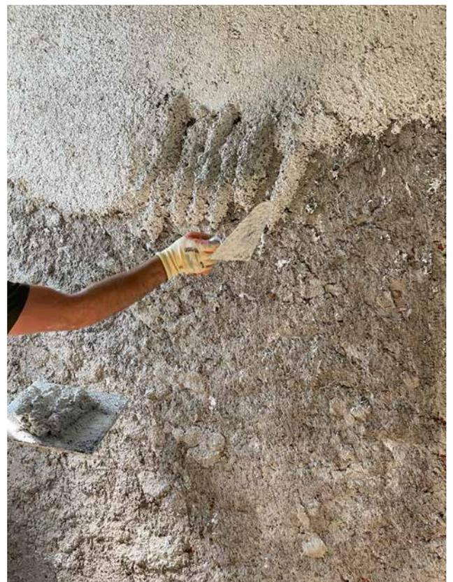
▲ Projection d'un enduit correcteur thermique chaux/chanvre
