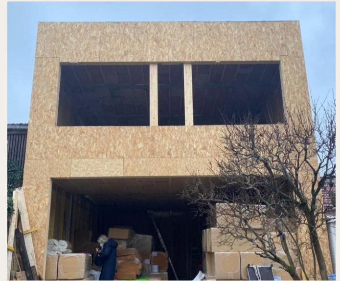
MAISON EN OSSATURE BOIS – SEINE-SAINT-DENIS
