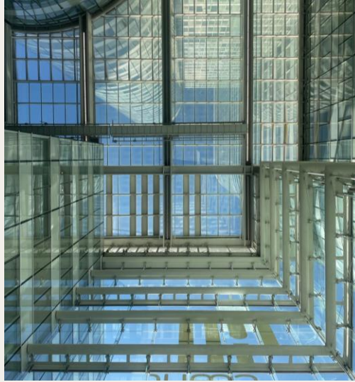
VISITE DE CŒUR DÉFENSE : élaboration du diagnostic de performance énergétique
