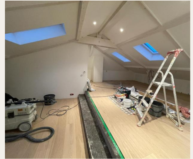
POSE DU PARQUET DANS LES COMBLES
