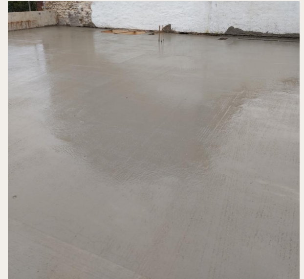
COULAGE DE LA DALLE BETON AU R+1
