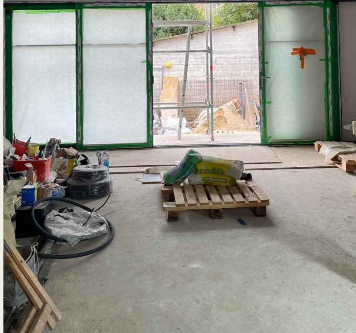
INSTALLATION DE LA BAIE DU RDC
