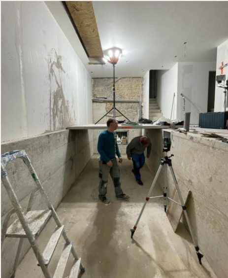
PISCINE EN SOUS-SOL
