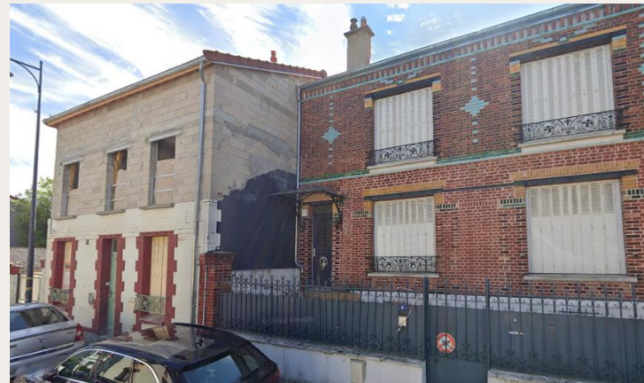
CHANTIER : façades des deux maisons à connecter et surélévation de l'une d'entre elles
