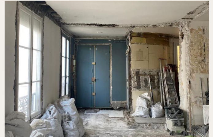
RENOVATION D'UN APPARTEMENT – PARIS VI – PHASE DEMOLITION
