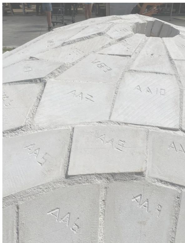
Gravure des pierres une à une pour s'y retrouver lors du montage. Suivi d'un plan pour le positionnement et mise en œuvre stratégique pour que les pierres ne s'écroulent pas.
